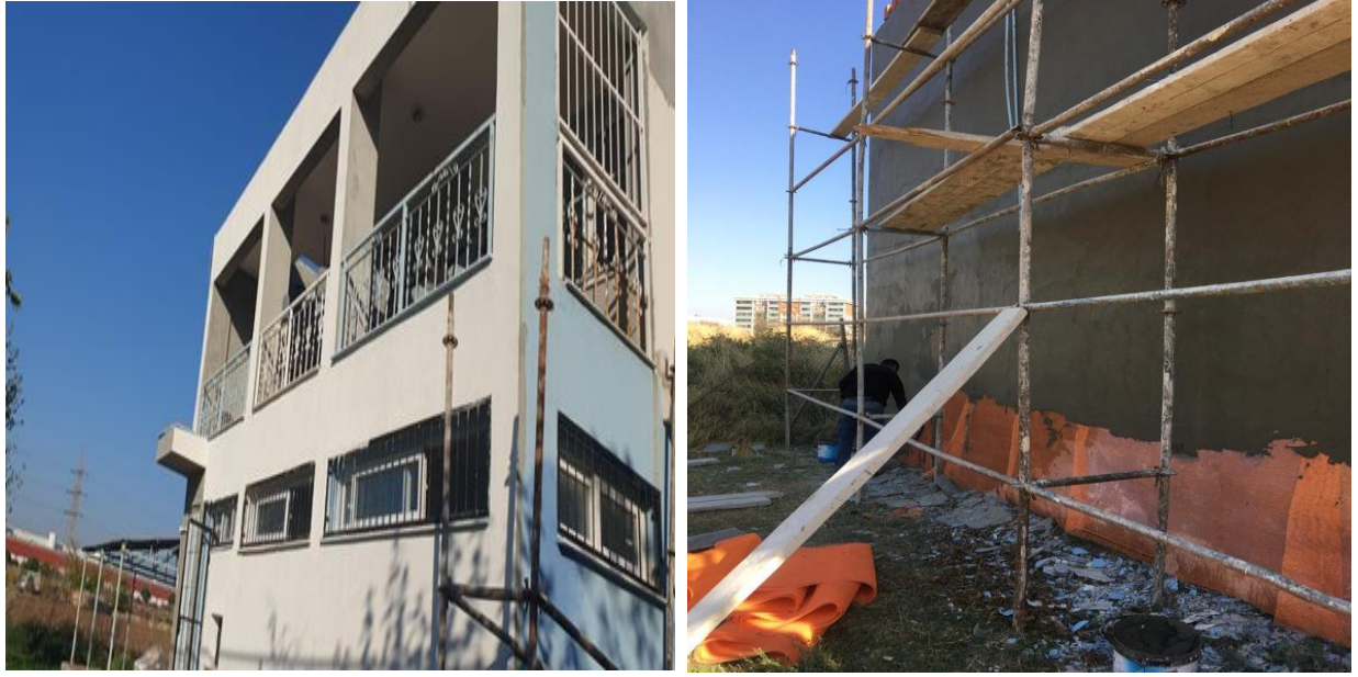
Resim 177 Dadaşspor Kulübü Binasında Dış Cephe Tadilatı
