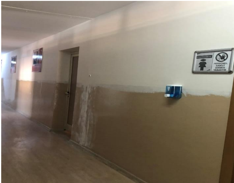
Resim 176 Bakım-Onarım Ve Tadilat Faaliyetleri
