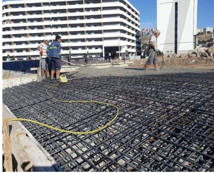
Resim 173 Yaya Köprüsü Yapılması
