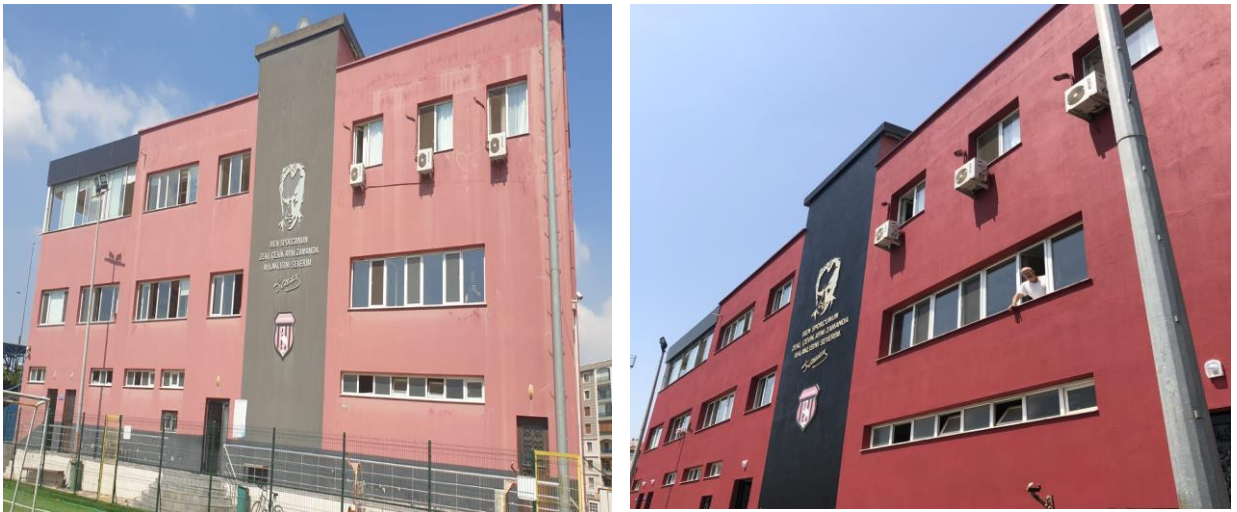
Resim 178 Atatürk Stadı İdari Binasında Dış Cephe Tadilatı
