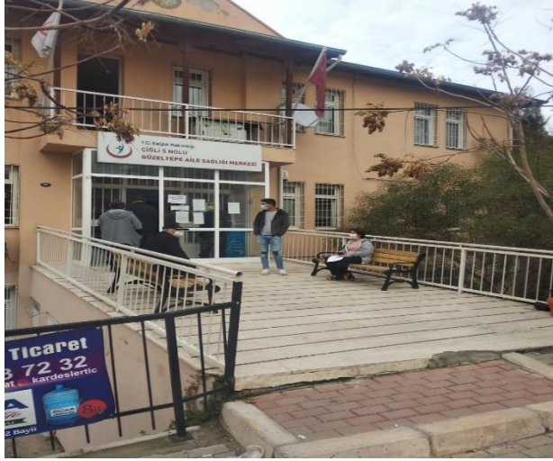
Resim 190 Güzeltepe Aile Sağlığı Merkezinde Sundurma Yapılması
