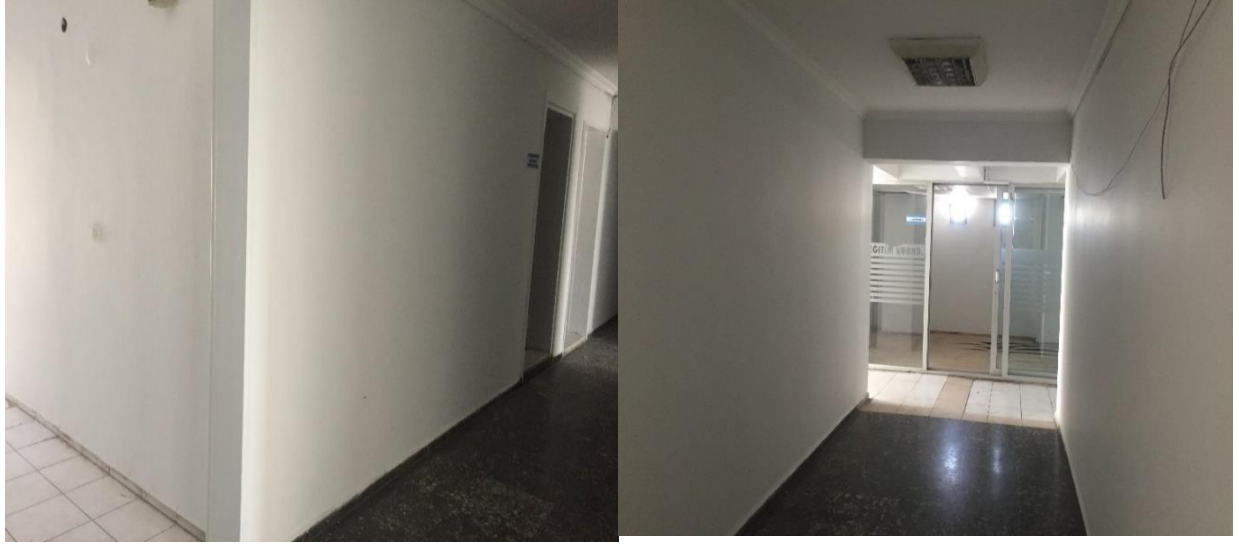
Resim 183 Kadın ve Aile Hizmetleri Müdürlüğü Binasında Bakım Onarımı
