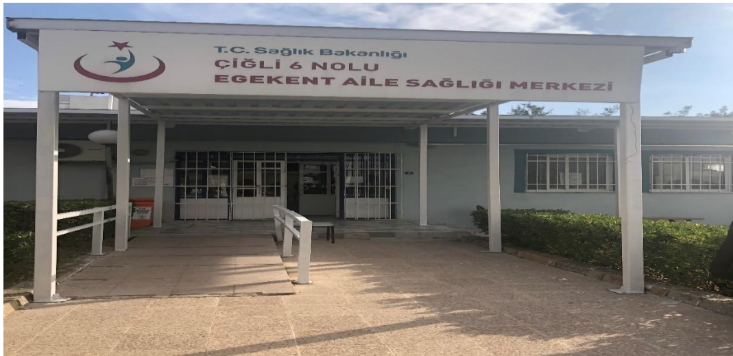
Resim 191 Egekent Aile Sağlığı Merkezinde Sundurma Yapılması
