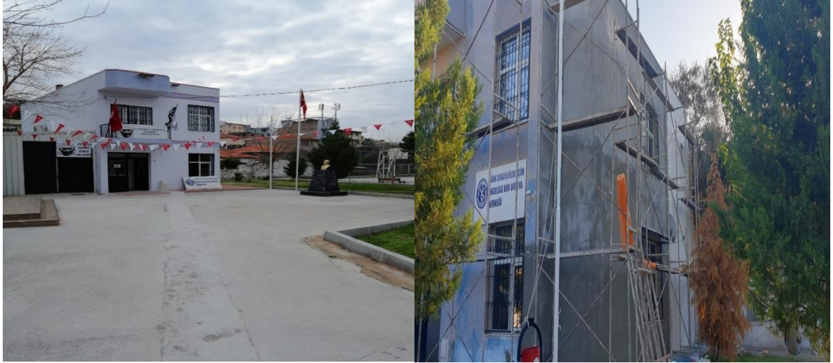
Resim 179 Engelli Merkezinde Dış Cephe Tadilatı
