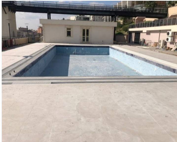
Resim 174 Açık Yüzme Havuzu Yapılması
