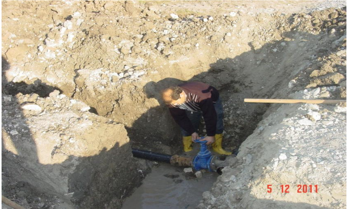
ÇETİN YELMEZ BULVARI İÇMESUYU HATTI ÇALIŞMASI
