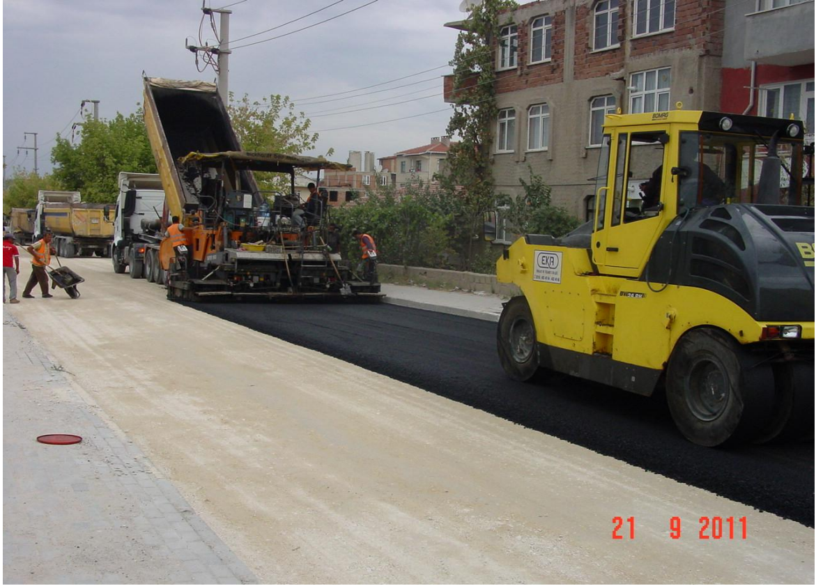
SAKIZKÖY CADDESİ SICAK ASFALT ÇALIŞMASI
