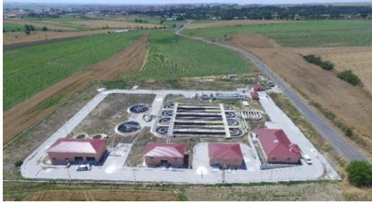
Hayrabolu Atıksu Arıtma Tesisi
