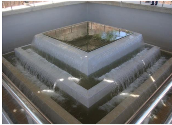
Ordu-Ünye İçmesuyu Arıtma Tesisi
