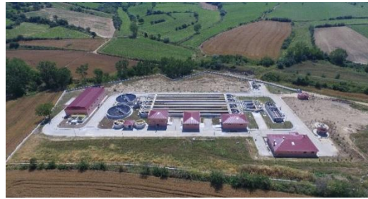
Malkara Atıksu Arıtma Tesisi
