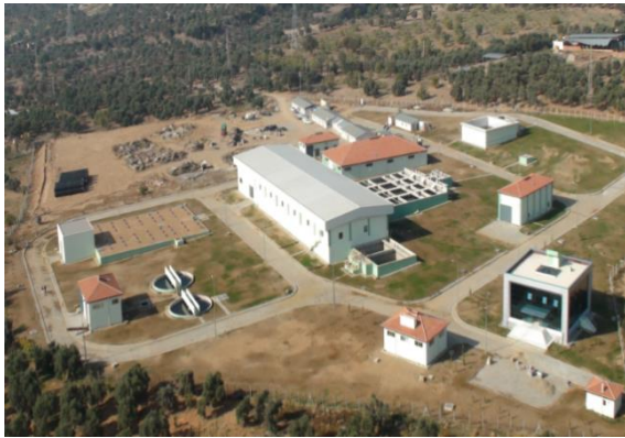
Aydın İçmesuyu Arıtma Tesisi
