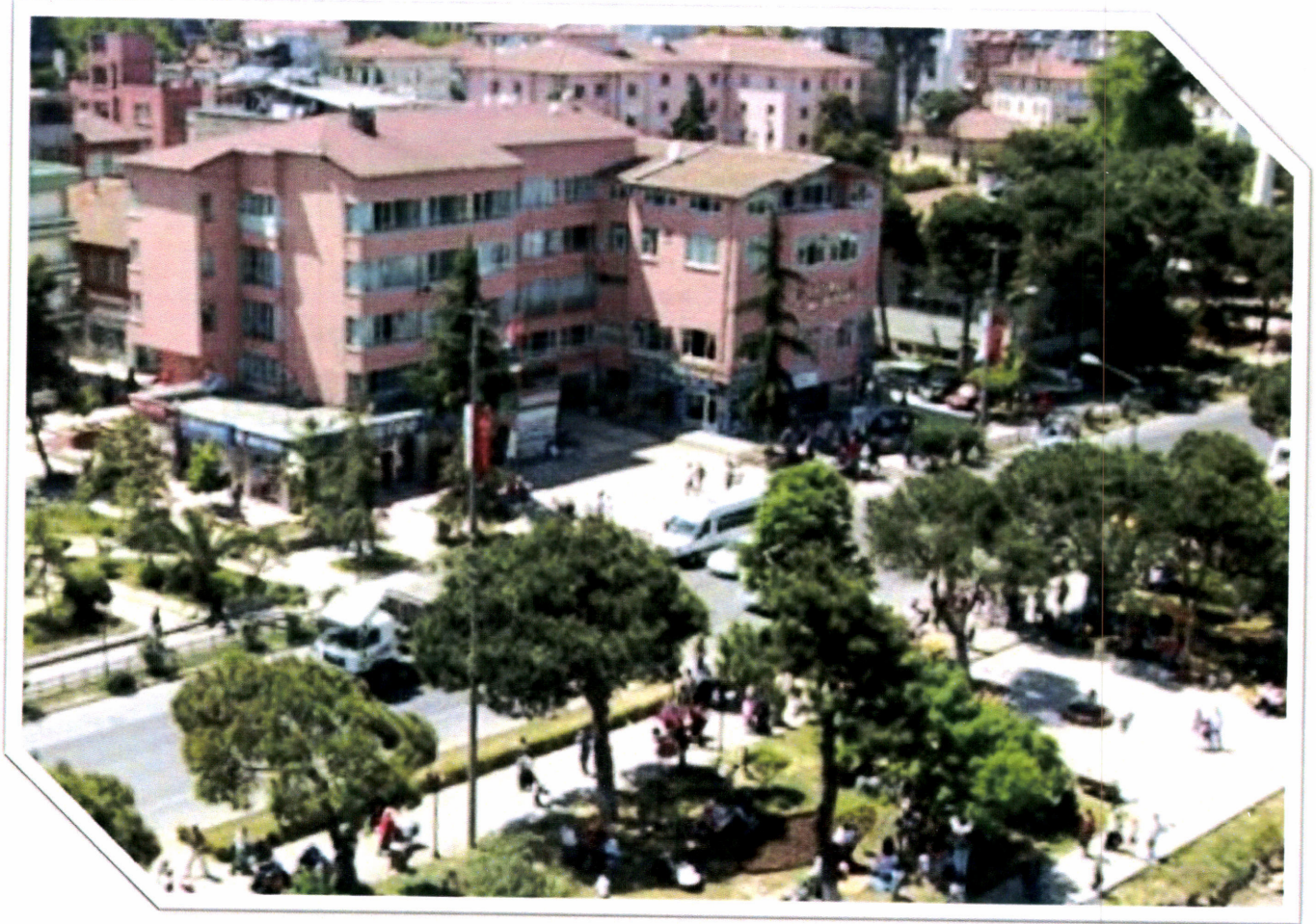
Kaledere mahallesi Belediye Caddesinde Cumhuriyet Meydanı yanında konumlanan Ünye Belediye Başkanlığı binası ve bu binada bulunan müdürlükler
