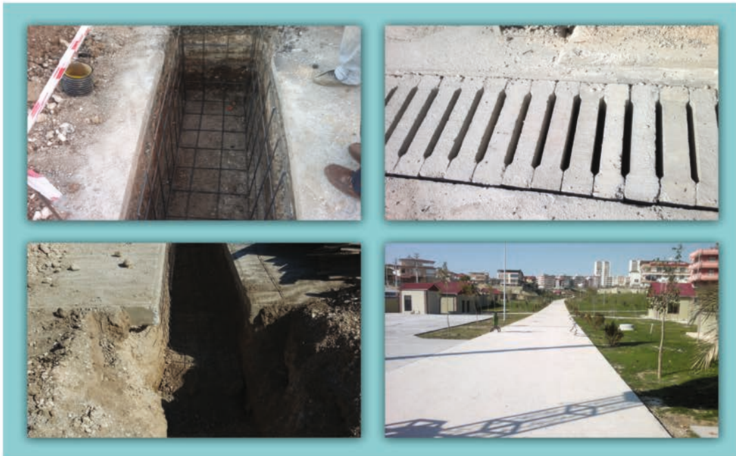
Resim 11. Vadi Park Yağmursuyu İzgara Çalışmaları
