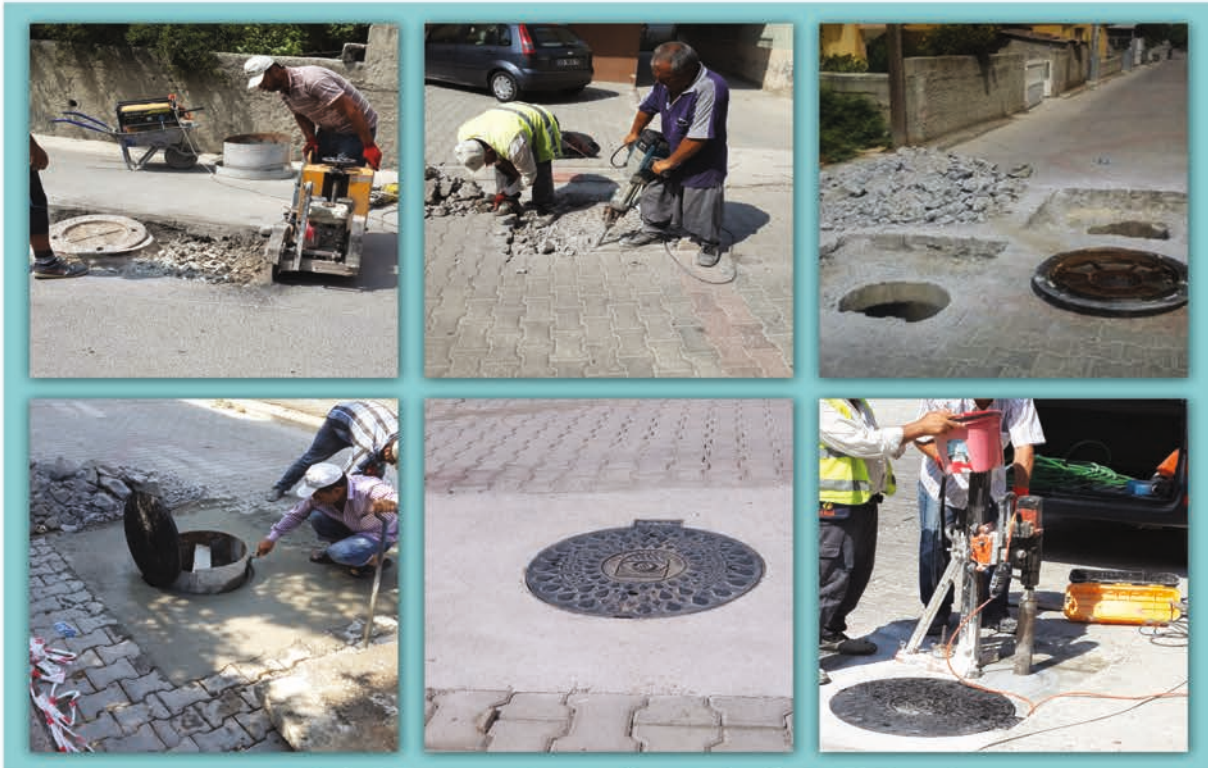
Resim 6. Kanalizasyon Baca Kapaklarının Yükseltilmesi ve Yenilenmesi
