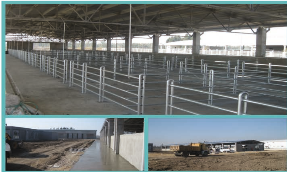
Resim:10 – Yeni Mezbahane ve Yeni Hayvan Pazarına İçme Suyu Borusu Döşenmesi
