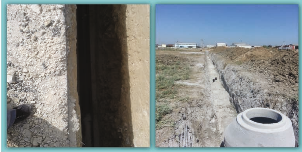
Resim 3. Kanalizasyon Borusu Döşenmesi Çalışmaları
