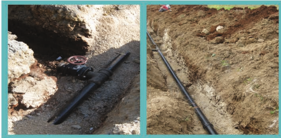
Resim:7 – Pvc İçme Suyu Borusu Döşenmesi
