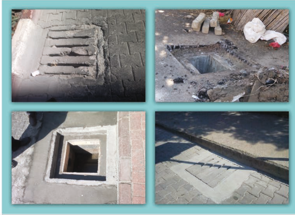
Resim 7. Yağmursuyu Izgaralarını Yükseltme Çalışmaları
