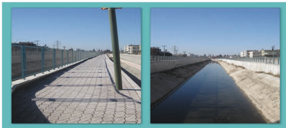
Resim:11 – Perde Duvar ve Kaldırım Yapılması
