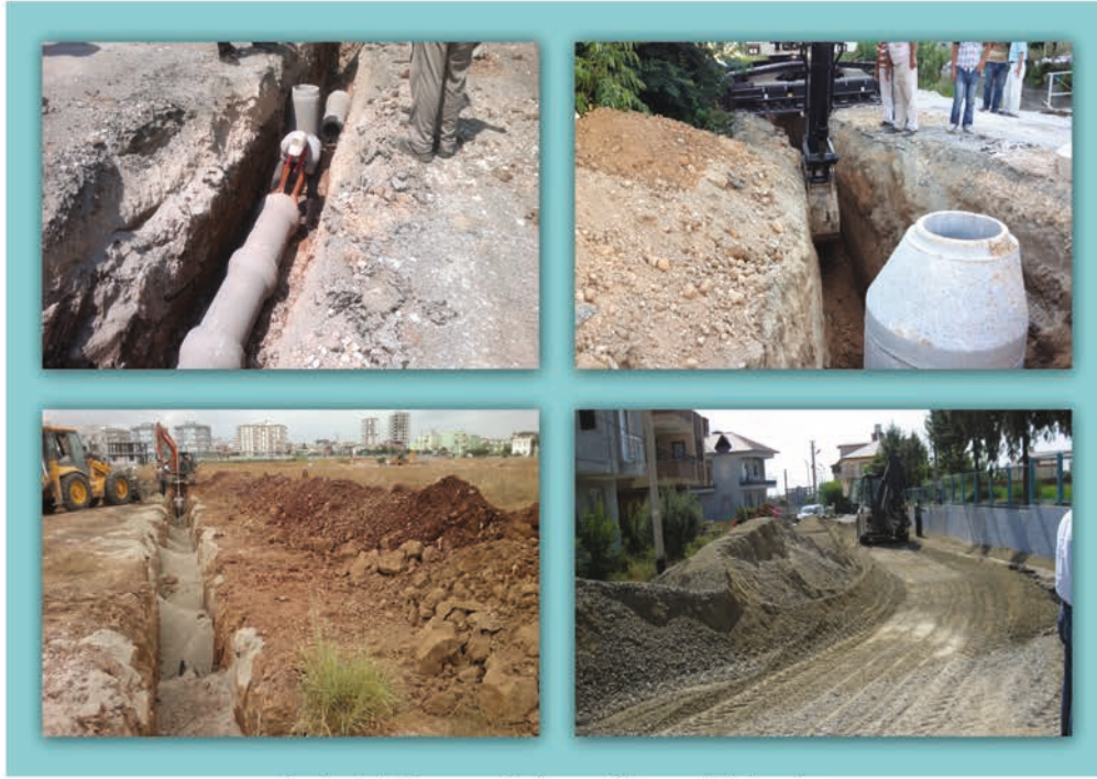
Resim 4. Yağmursuyu Hatlarının Döşenmesi Çalışmaları
