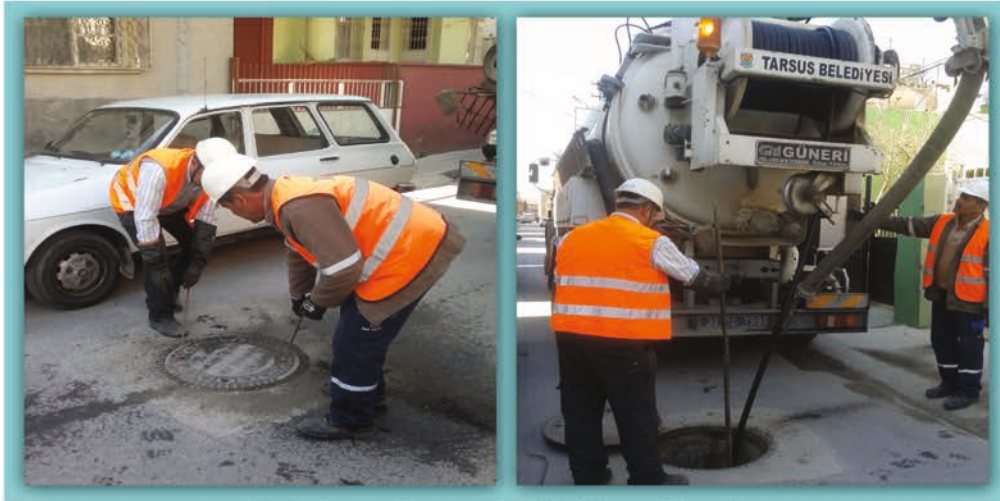
Resim 3a. Kanalizasyon Tıkanıklık Giderme Çalışmaları
