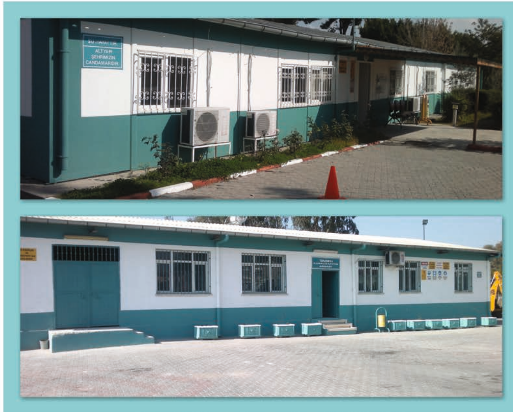
Resim 1. TASKİ Kanalizasyon ve Drenaj İşleri Yöneticiliği
