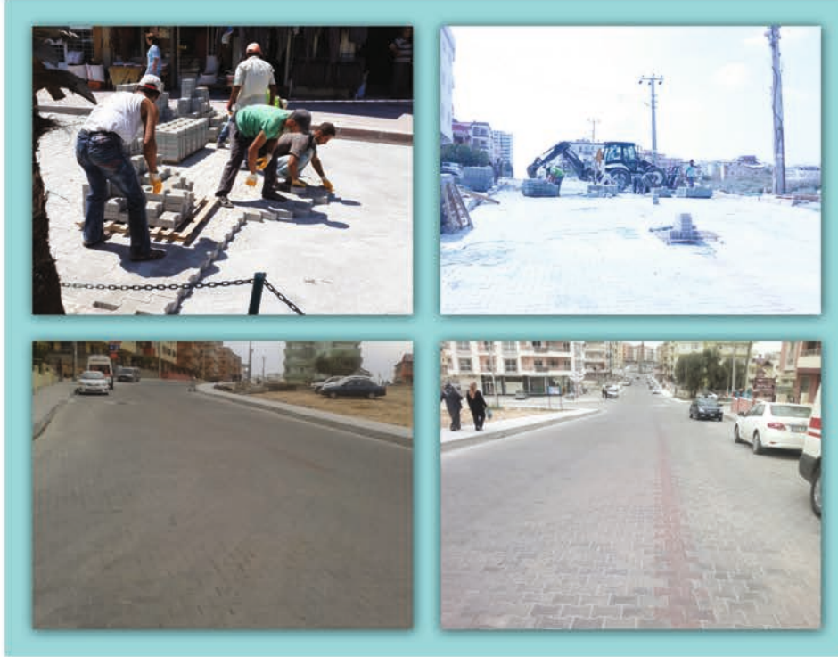
Resim 9. Parke Kaplama Yapılması Çalışmaları
