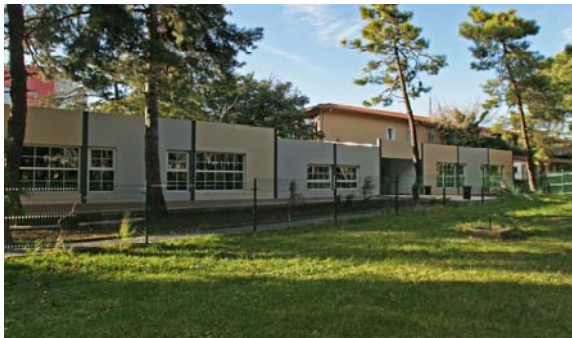
Yapımı tamamlanan Z blok
