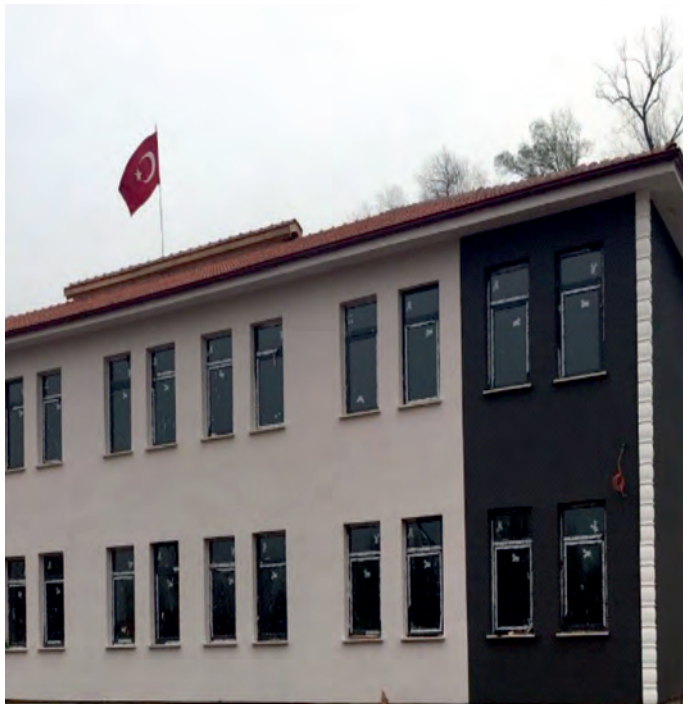
Evrenköy 8 Derslikli Ortaokul Yapımı
