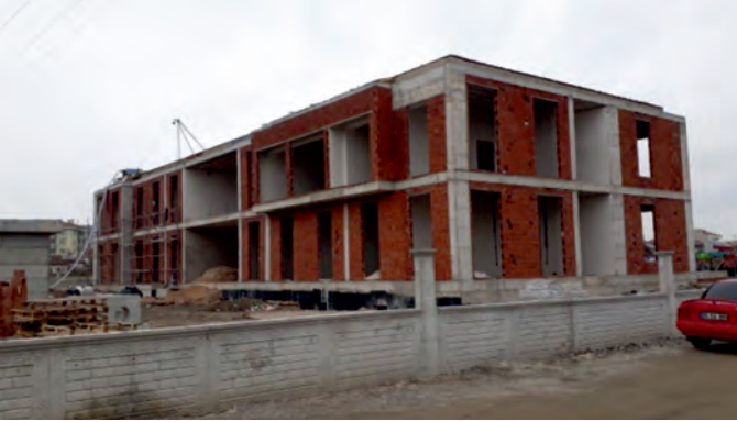
Zile İlçe Müdürlüğü Yeni Hizmet Binası İnşaatı
