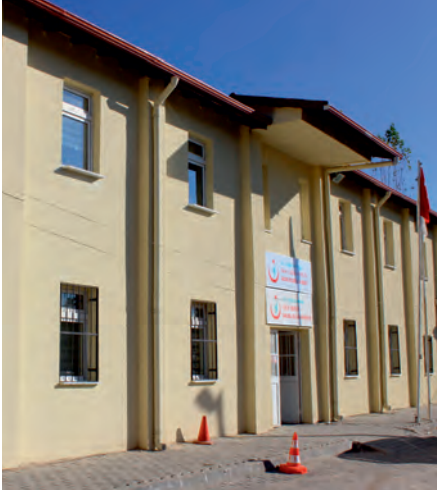
Çamlıbel Entegre Sağlık Tesisi Tadilat ve Onarımı
