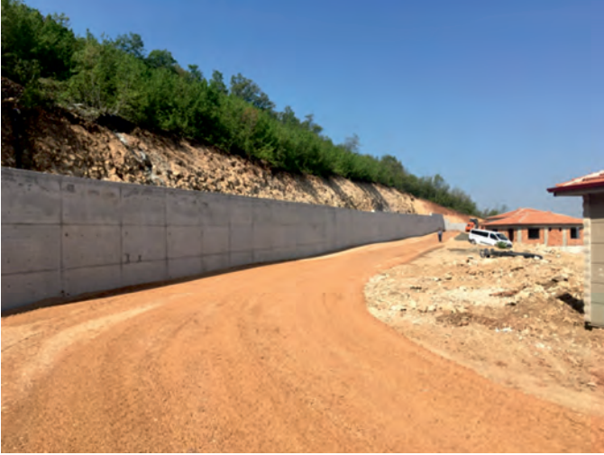
Pazar İlçesi Bağlarbaşı Köyü Altyapı ve Çevre Düzenleme İşi
