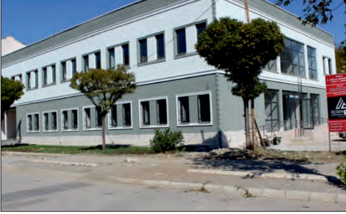
Turhal 2 Ekiplik 112 Ashi Ve 9 Hekimlik Asm Hizmet Binası Yapım İşi
