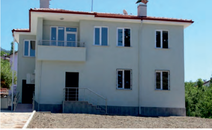
Niksar Serenli Sağlık Evi Yapım İşi
