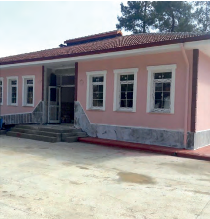
Alacabal 4 Derslikli İlkokul Yapımı
