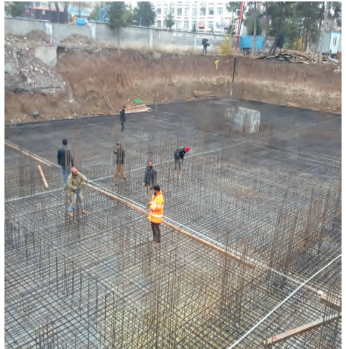
Fevzi Çakmak 24 Derslikli Ortaokulu (YIKYAP)
