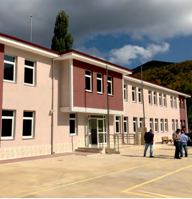
Semerciköyü 8 Derslikli İlkokulu Ekderslik Yapımı
