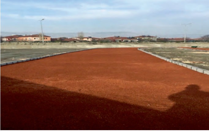
Turhal İlçesi Atletizm Pisti Yapım İşİ
