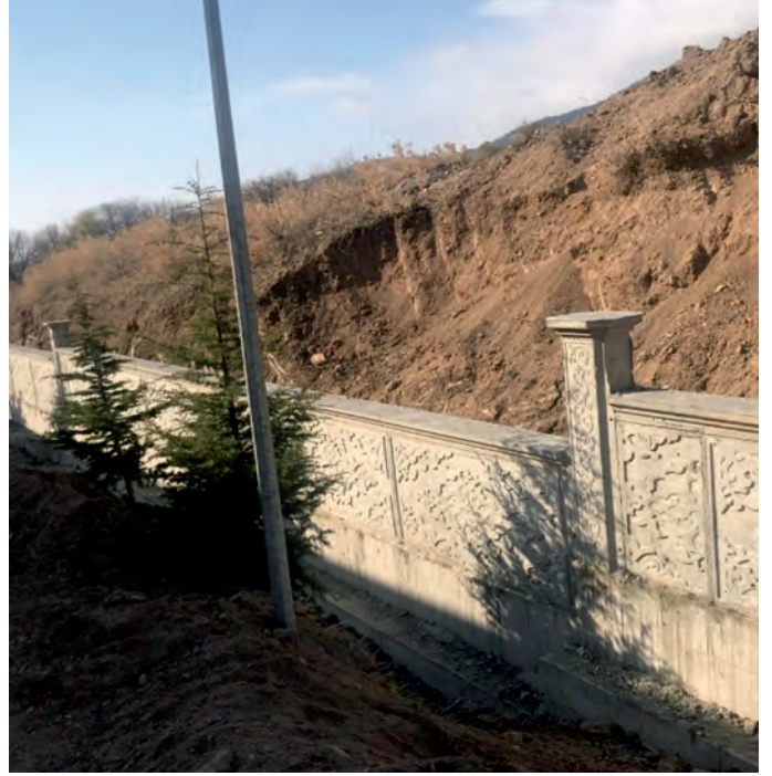
Dutluca Ksb.8 Derslikli İlkokul Yapımı
