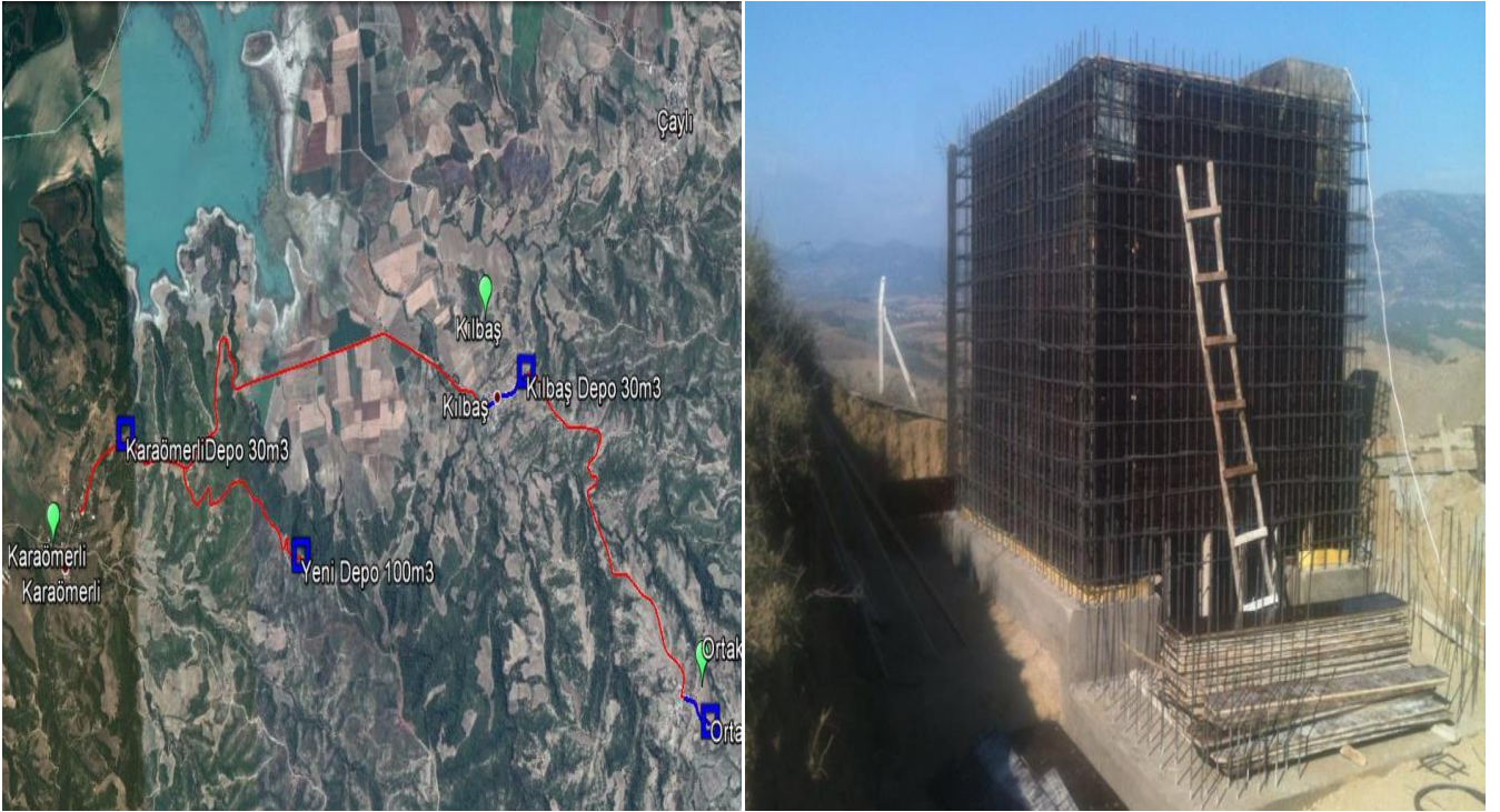
Sarıçam İlçesi Karaömerli - Kılbaş - Ortaköy İçmesuyu İsale Hattı Yapım Çalışmaları
