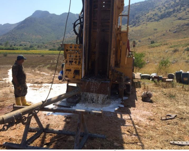
İçmesuyu Temini Amacıyla Sondaj Çalışması
