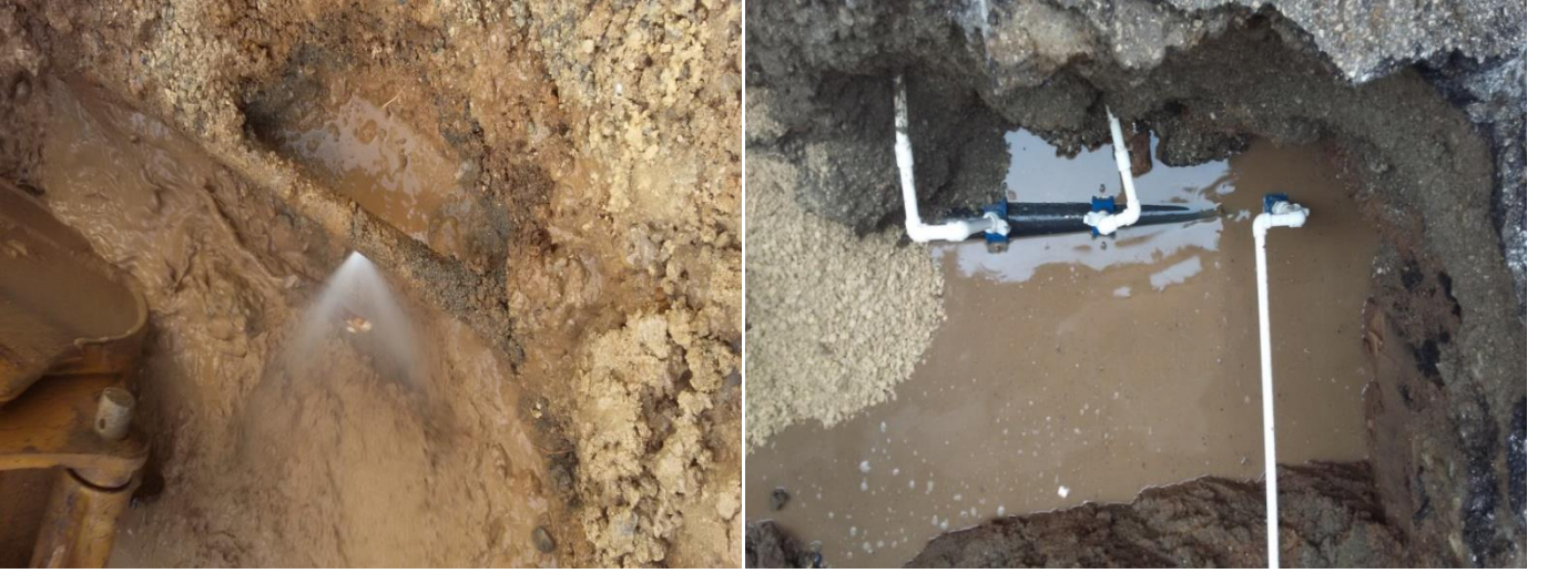
Galvanizli Abone Bağlantısı Yenileme Çalışması
