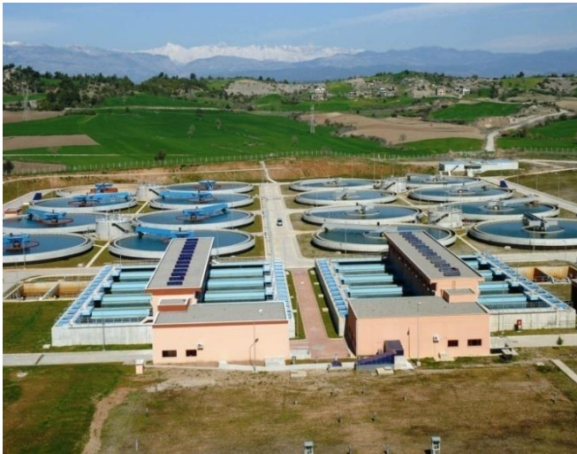
Çatalan İçmesuyu Arıtma Tesis
