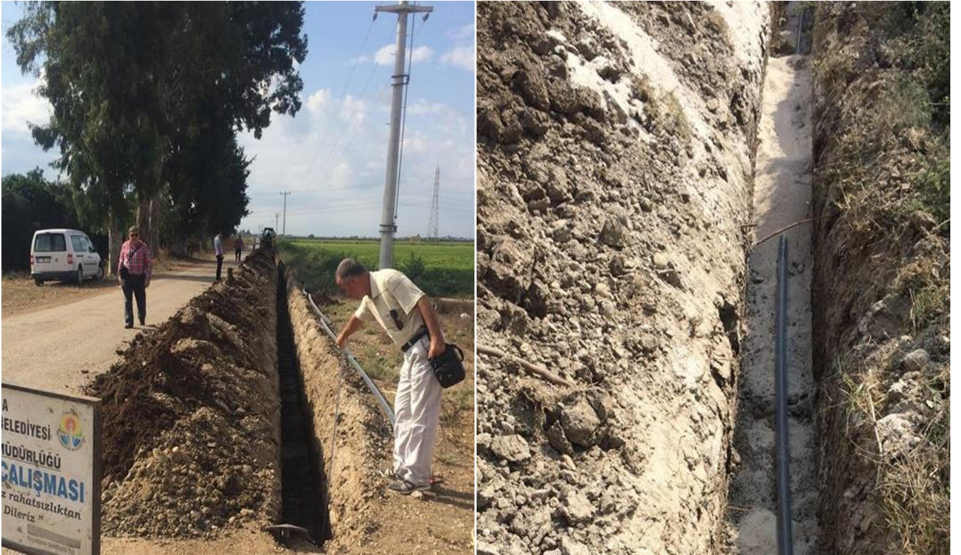
Alihocalı - Sağdıçlı İçmesuyu Şebekesi Yapımı Çalışmaları
