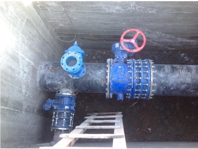
Vana Odası, Kaptaj Yapım ve Bakım Çalışmaları
