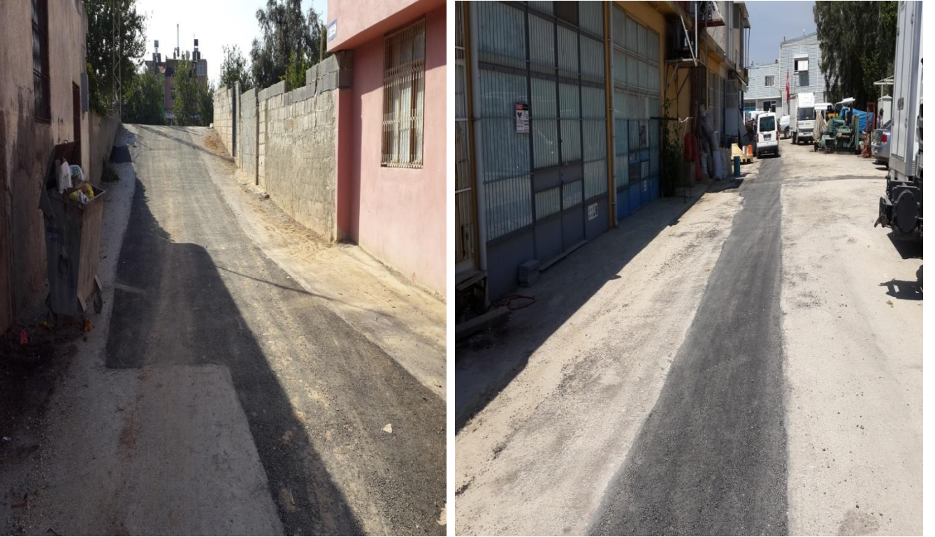
Muhtelif Mahalleler Asfalt Yapımı Çalışması
