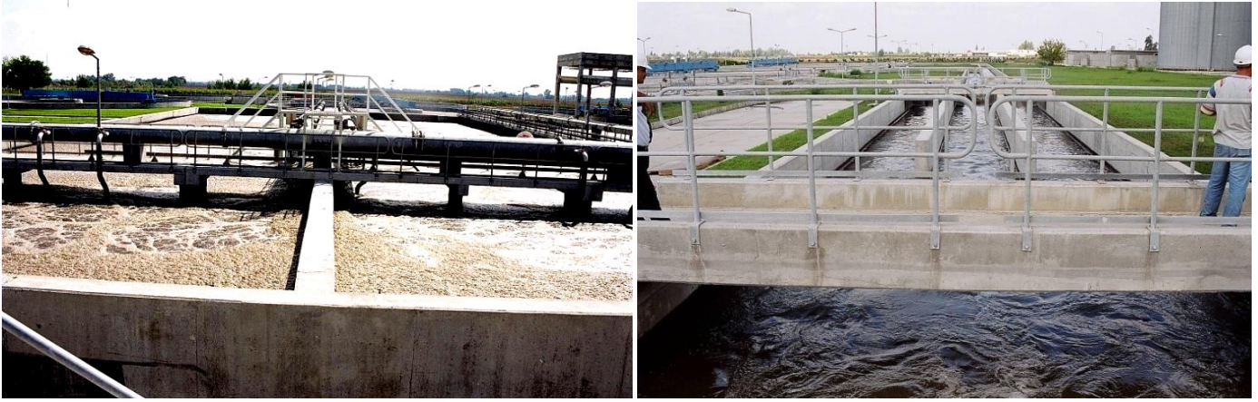
Seyhan Atıksu Arıtma Tesisi
