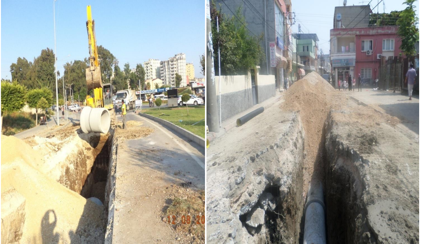
Mücahitler Bulvarı ve Gülbahçe Mah.Kanalizasyon Yapım Çalışması
