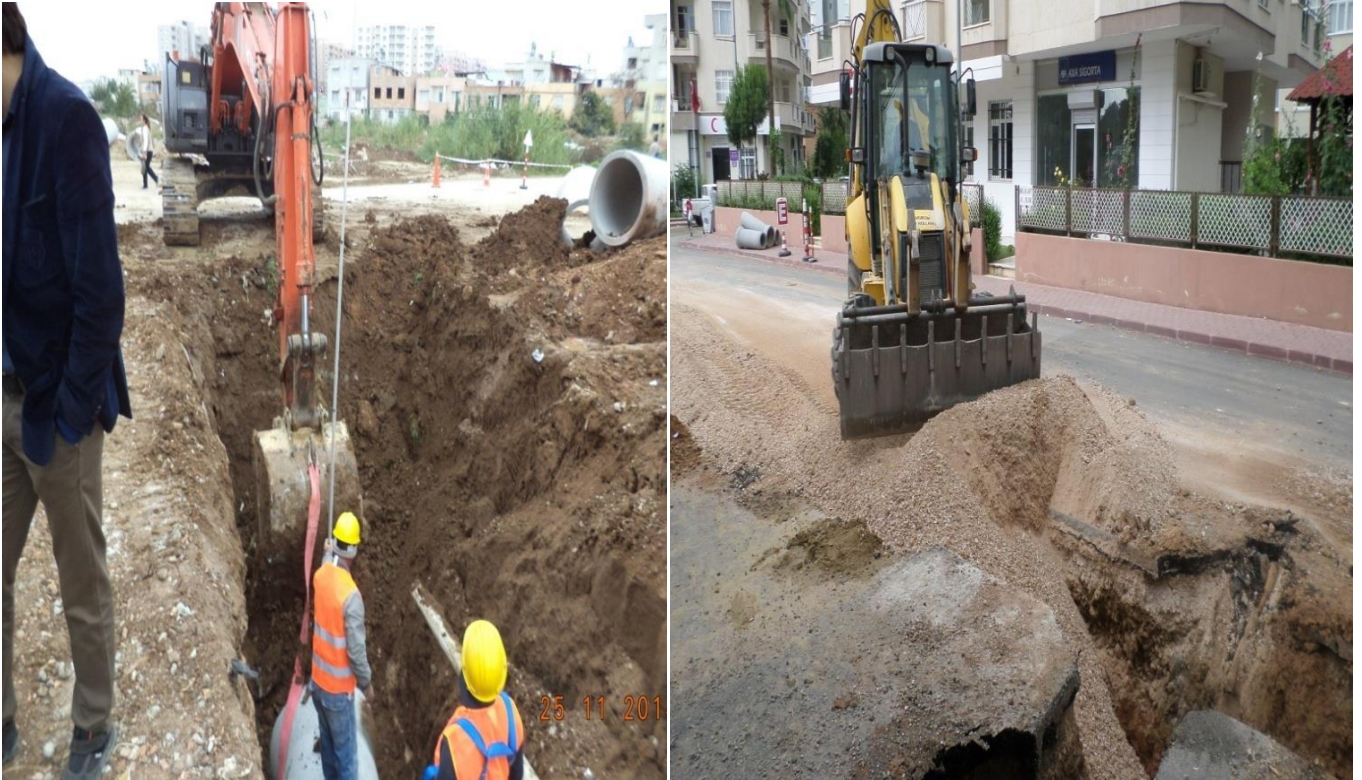
Beyazevler ve İsmetpaşa Mah.Kanalizasyon Şebeke Yapımı Çalışmaları
