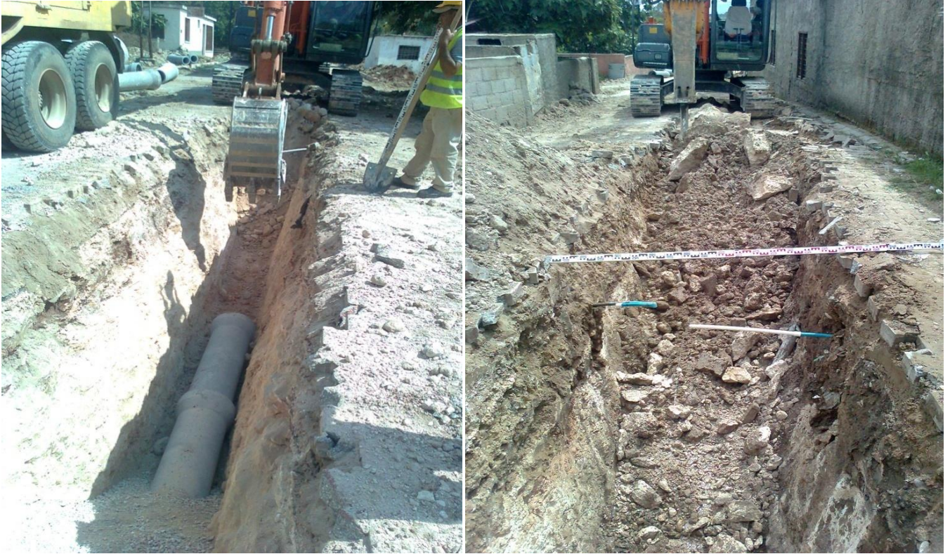
Kürkçüler Yürekli Mahallesi Kanalizasyon Yapımı Çalışmaları
