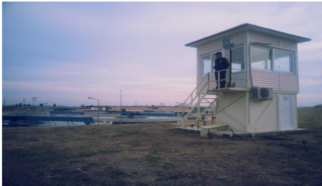
Çatalan İçmesuyu Tesisleri
