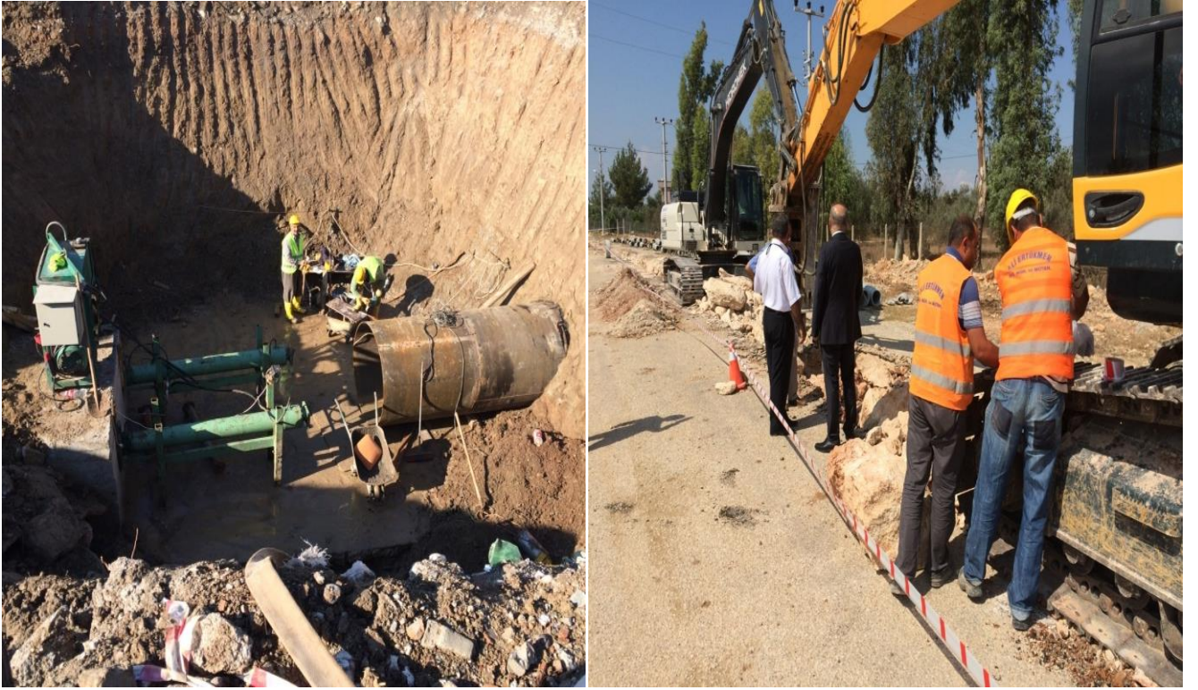
Narlıca Mahallesi ve Kürkçüler Mahallesi Kanalizasyon Çalışması
