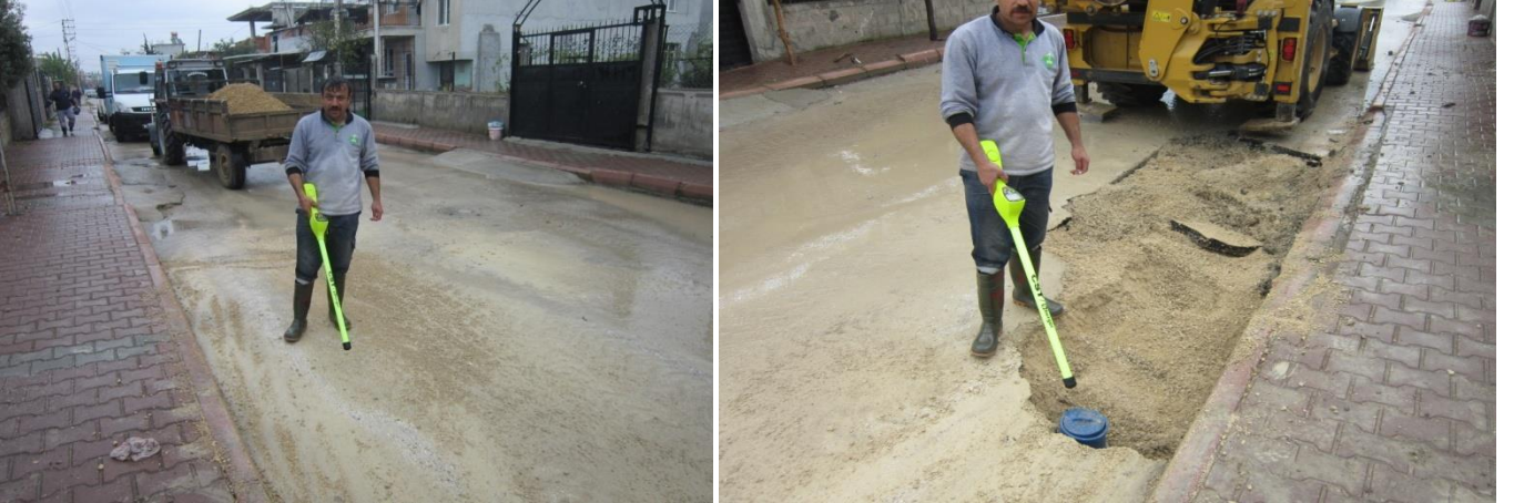
Vana Tespit ve Yenileme Çalışması
