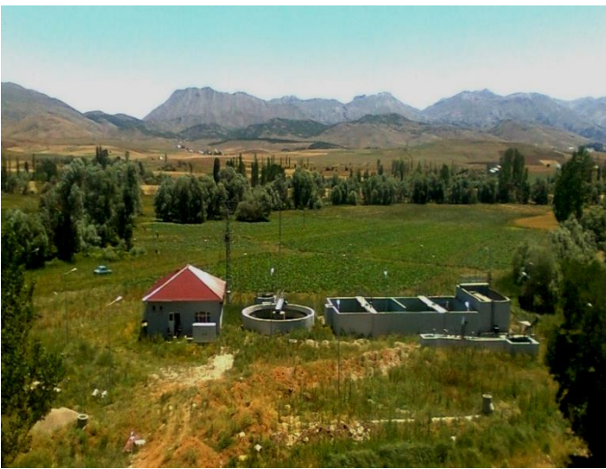
Tufanbeyli Atıksu Arıtma Tesisi
