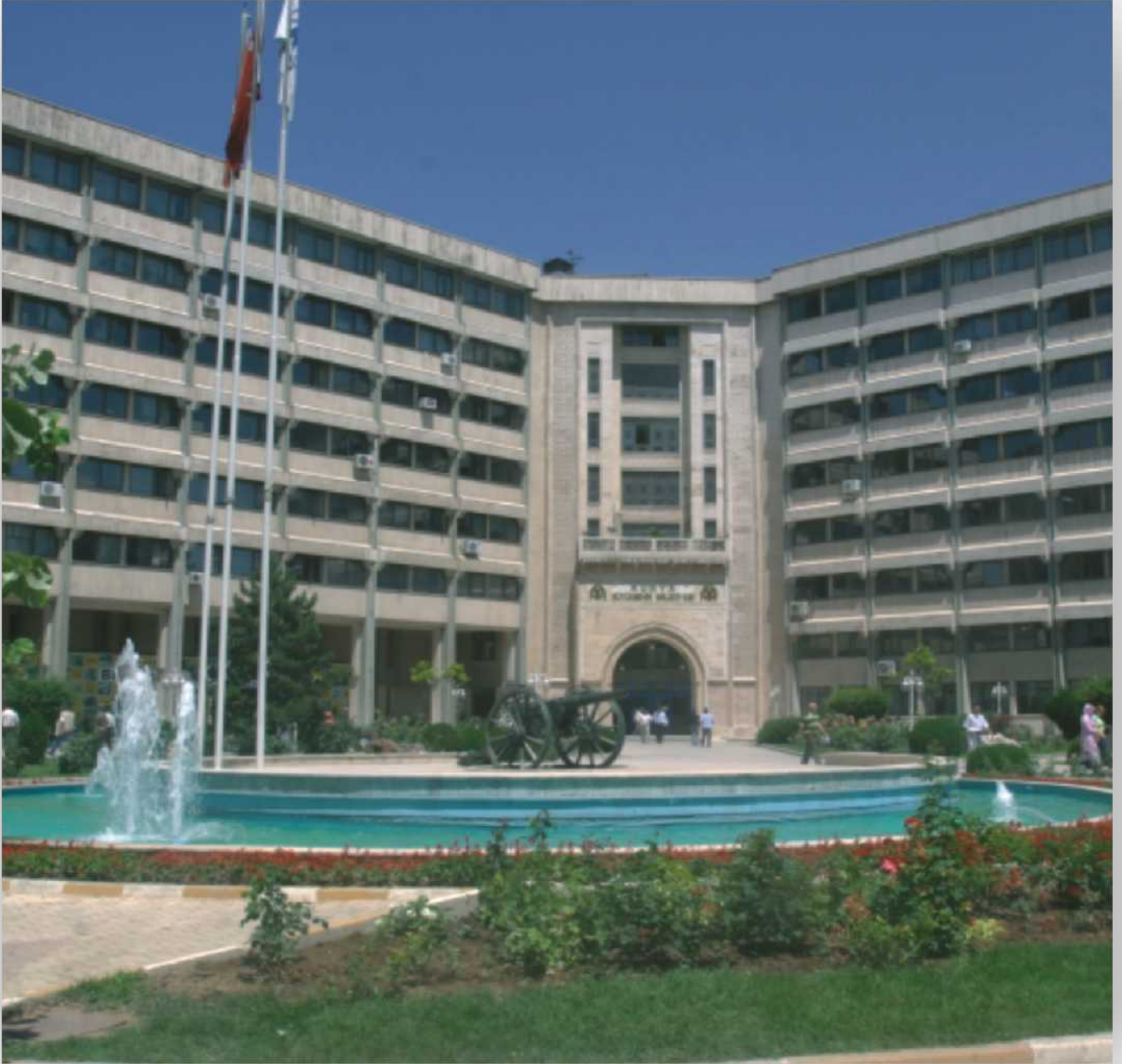
Konya Büyükşehir Belediye Binası
