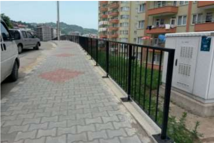
7. Teyyaredüzü mahallesi ikiz evler istinat duvarı üzerine yol kenarı korkuluk yapıldı.
