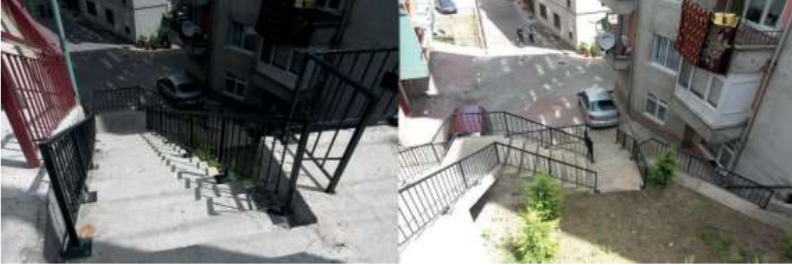
2.Gemilerçekeği mahallesi Sagae caddesinde merdiven korkuluğu yapıldı.
