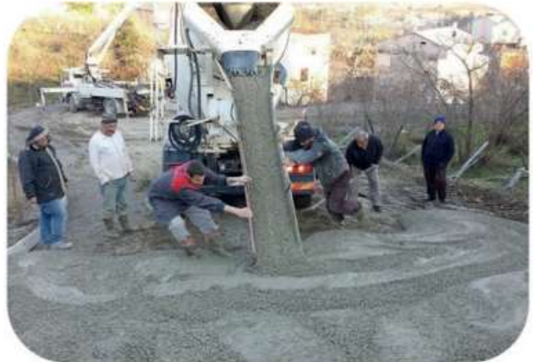
Aksu Mh. Konakyanı Mevkii
