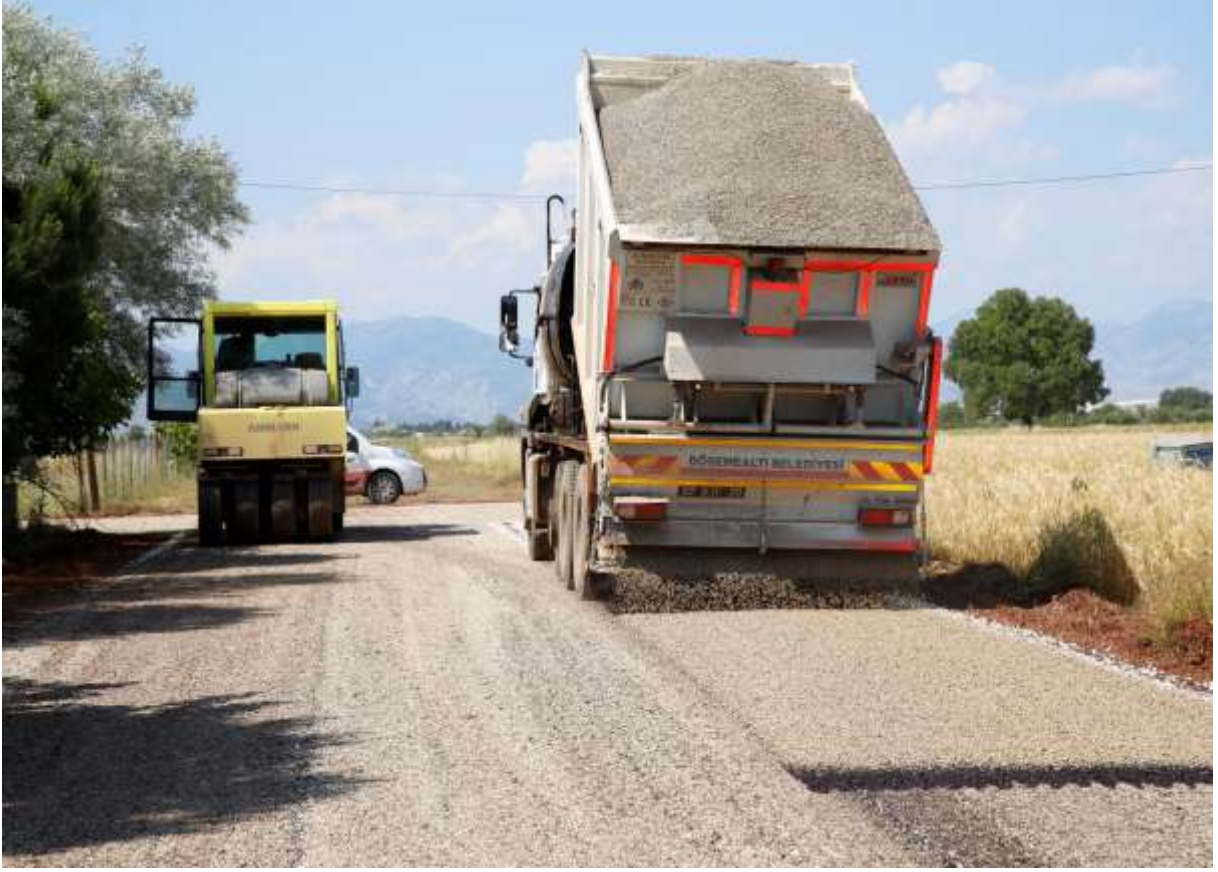
Muhtelif Kaldırım Alt Temel, Temel, Asfalt Kaplama İşi
