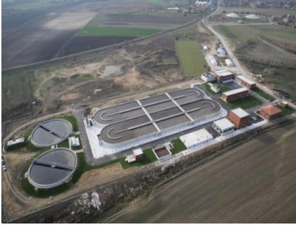
Şekil 9. Lüleburgaz Su ve Atıksu Projesi- Atıksu Arıtma Tesisi
