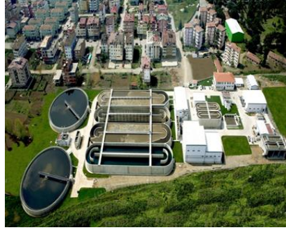
Şekil 10. Ordu Su ve Atıksu Projesi- Atıksu Arıtma Tesisi
