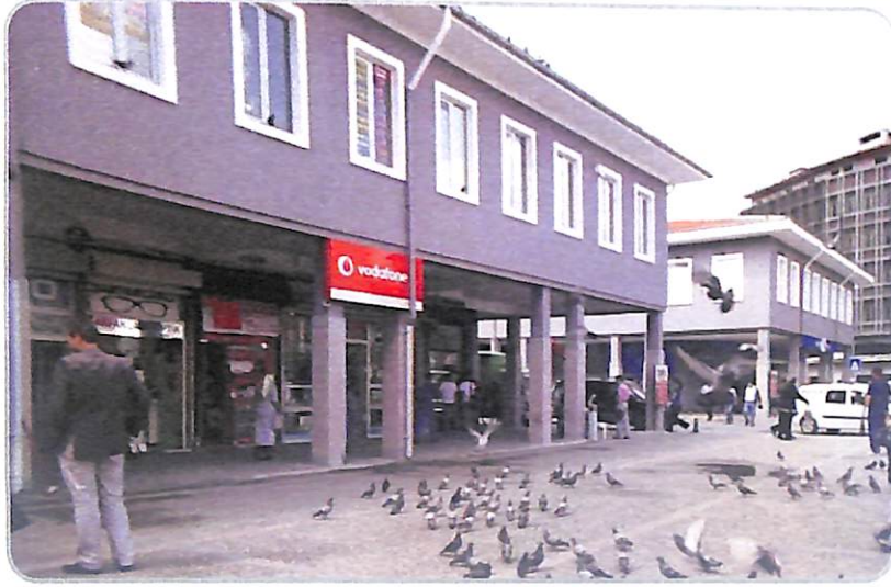
Yeni Çarşı Onarımı İşi Çalışmaları
