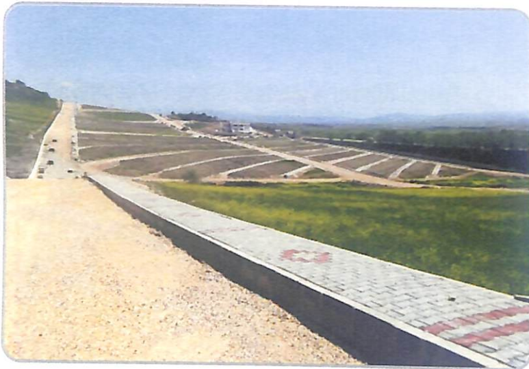
Çınarlıdere Mezarlığı Yapım Çalışmaları
