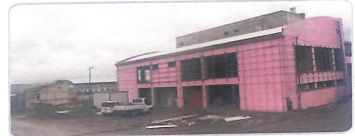
Spor Kompleksi Spor Salonu İnşaatı
