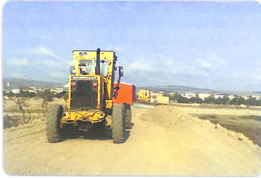
Yeni Sanayi Bölgesinde Yol Açma Çalışmaları
