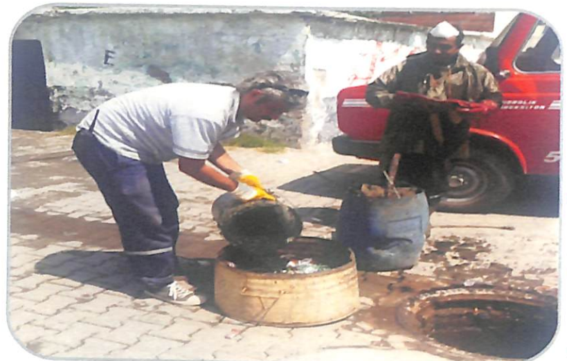
Kanalizasyon Muayene Bacası Temizliği
