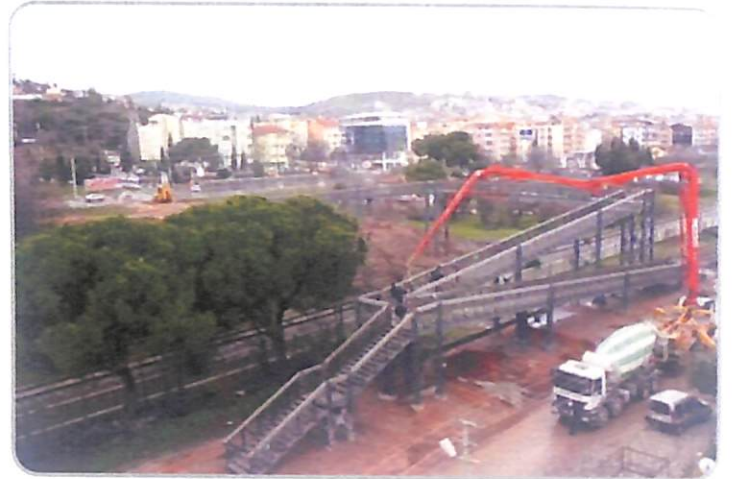
Demiryolu Üst Geçidi İnşaatı Çalışmaları
