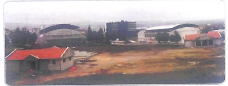
Spor Kompleksi İnşaatı
