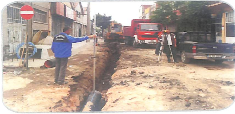
Yağmur Suyu Drenaj Hatları Yapımı - Yağmur Suyu Menfezi Yapım Çalışmaları
