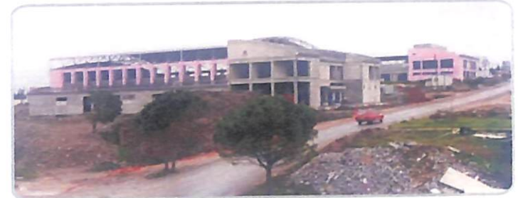
Spor Kompleksi Yüzme Havuzu İnşaatı
