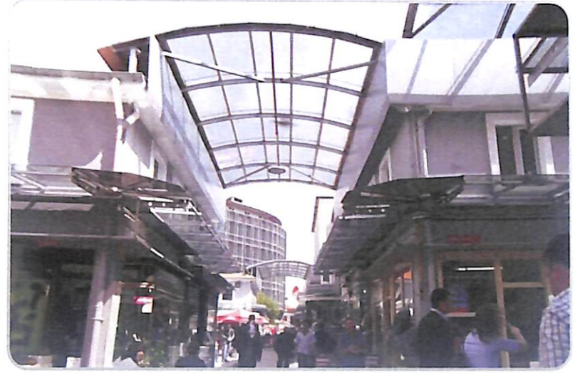
Yeni Çarşının Onarımı İşi Çalışmaları
