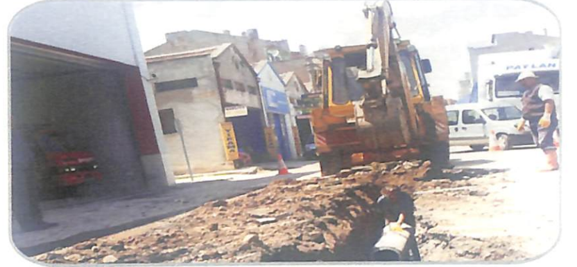
Yağmur Suyu Drenaj Hatları Yapımı - Yağmur Suyu Menfezi Yapım Çalışmaları
