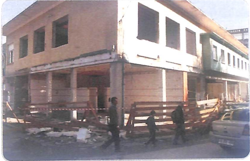
Hal Binası Yıkım Çalışmaları
