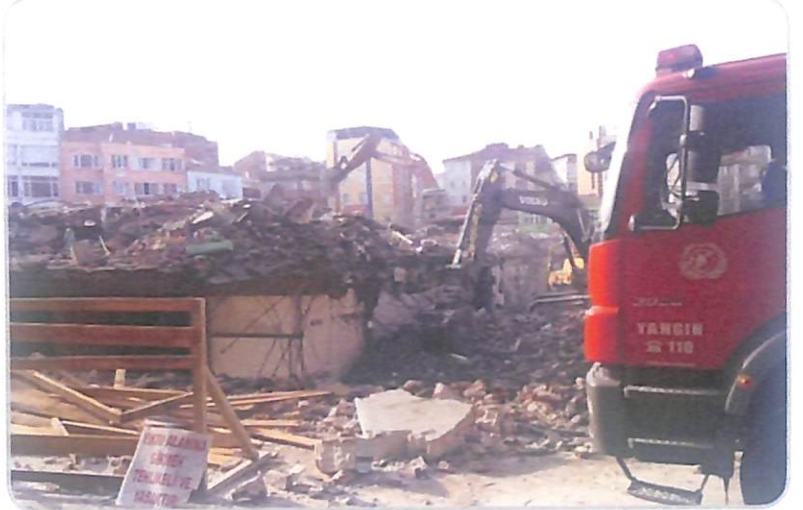
Hal Binası Yıkım Çalışmaları
