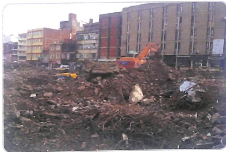
Hal Binası Yıkım Çalışmaları
