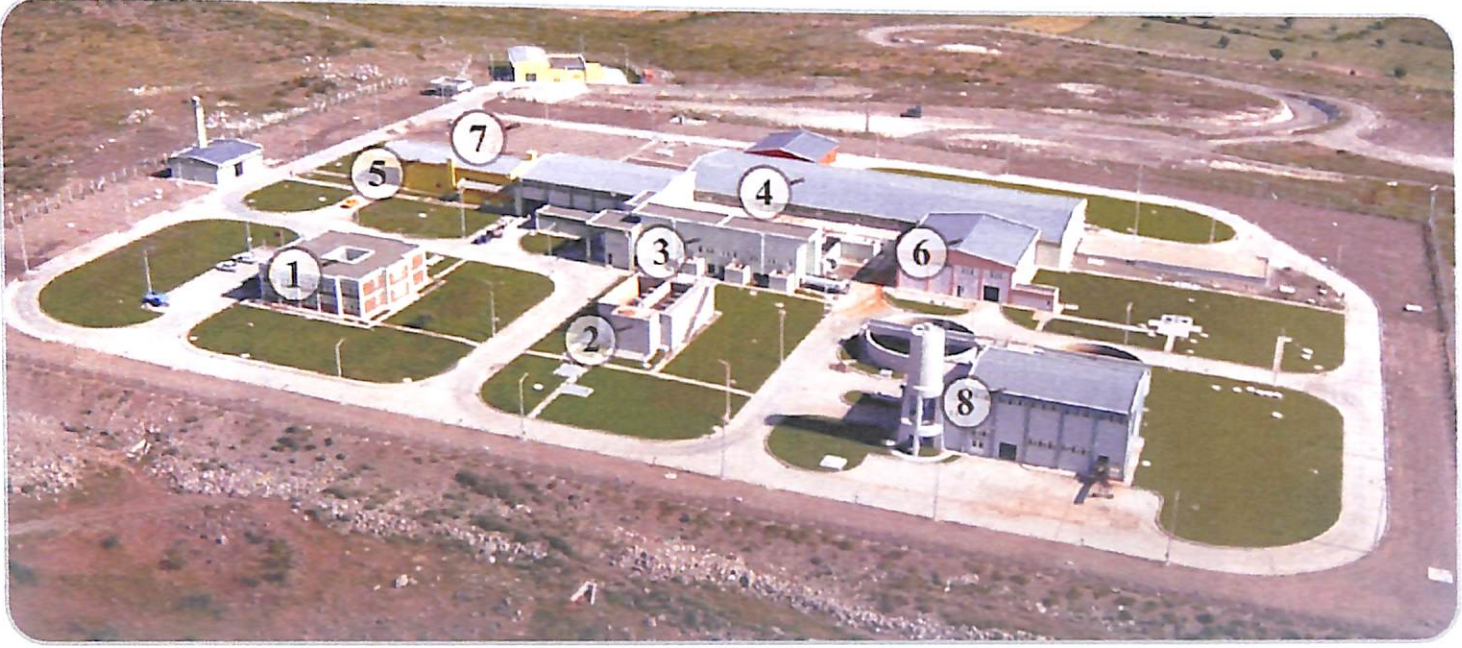
İçme Suyu Arıtma Tesisi
