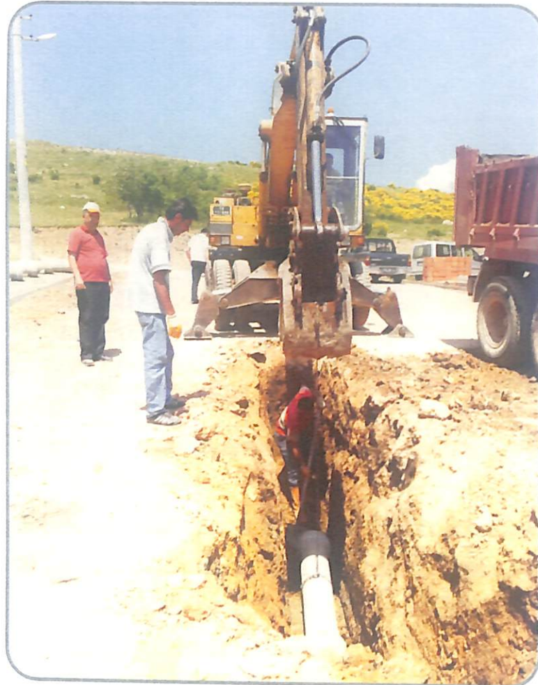
Kanalizasyon Şebekesi Yapımı
