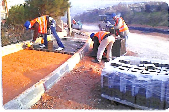
Dinkçiler Mahallesi Yol ve Tretuar Yapım Çalışmaları
