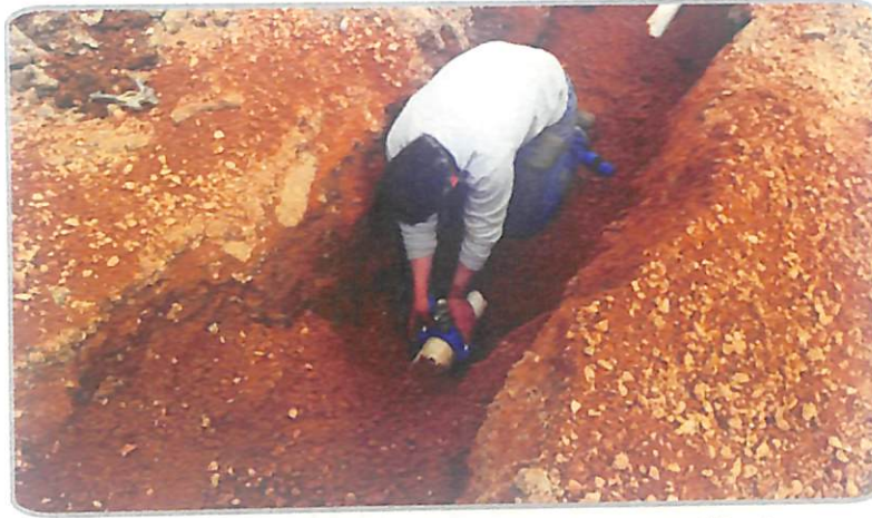
Su Ana Şebeke Borusu Yapımı ve Abone Bağlantısı
