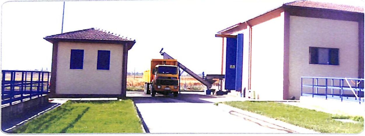
Atıksu Arıtma Tesisi Belt Pres Çamur Çıkışı
