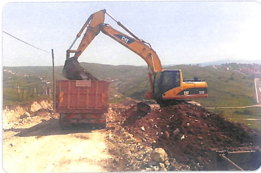
2. Sakarya Mahallesi Yol Açma Çalışmaları
