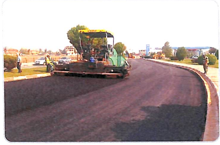
Yeni Terminal Yol Asfaltlama Çalışmaları
