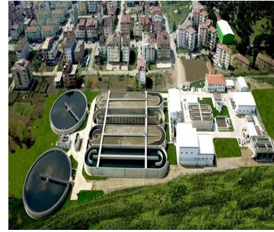
Şekil 18. Ordu Su ve Atıksu Projesi- Arıtma Tesisi
