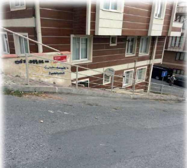
Korkuluk İmalat-Montaj Çalışması
