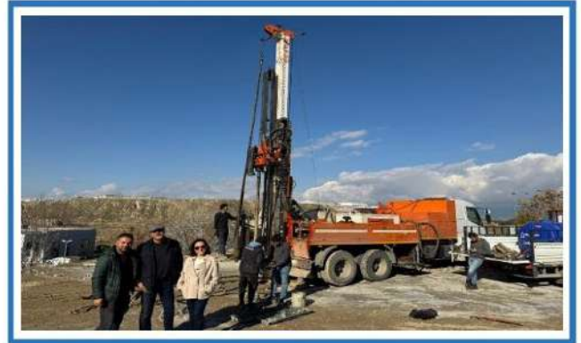
Saruhan Mahallesi Sismik Ölçüm Çalışması
