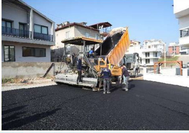
Fen İşleri Müdürlüğü - Yol Açma Çalışmaları
