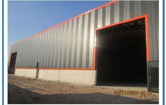
Akçeşme Mahallesi Atölyeye Ait İskan Kontrolü
