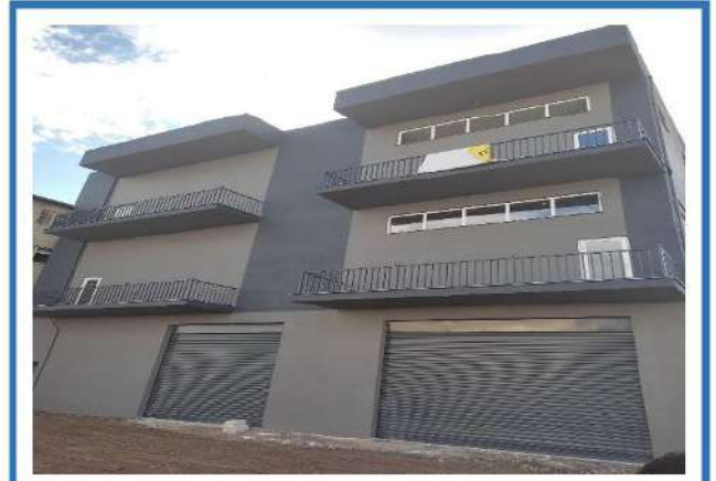
Akçeşme Mahallesi İşyerine Ait İskan Kontrolü
