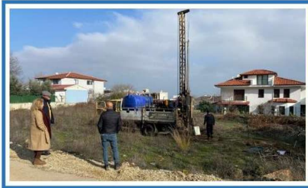
Yeşiköy Mahallesi Sondaj Çalışması
