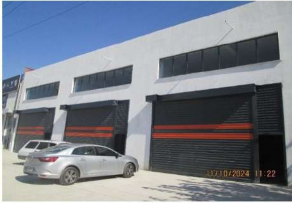
Sümer Mahallesi İmalathaneye Ait İskan Kontrolü
