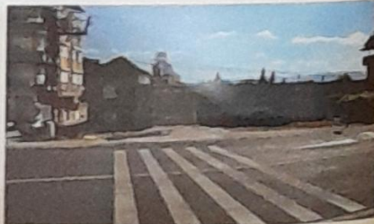
Güzelköy Yol Asfalt ve Durak Yapımı
