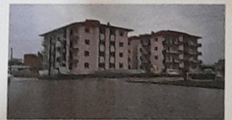
Karaçay Mah. Kentsel dönüşüm Konutları
