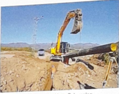
Yağmurlama Hattı Çalışmaları
