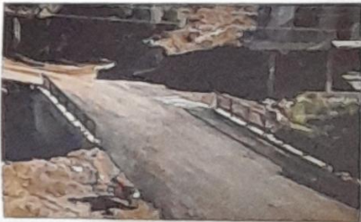
Bağcıllı Köyü Köprüsü
