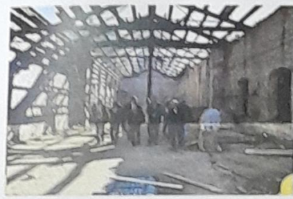
TCDD Hangar Restorasyon Çalışmaları
