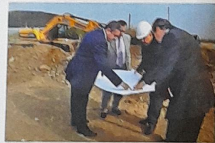
OSB Çevre Yolu Çalışmaları
