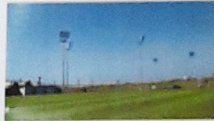
Esat Ergüler Spor Tesisleri Aydınlatılması
