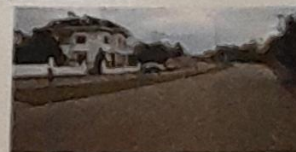
61 sokak Yeni tamamlanmış hal
