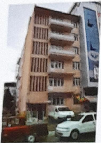
Yabancı Diller Okulu Yenileme Çalışmaları
