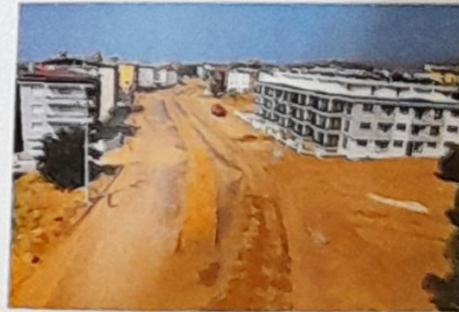
61 sokak yapım aşamasından görünüş
