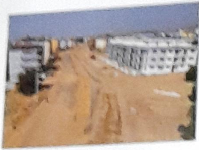
61 Sokak Yol Yapım Çalışmaları
