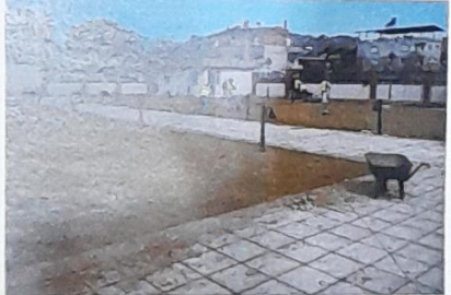
Arslanlı Kır Dügün Salonu düzenleme yapım aşaması
