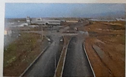
OSB Çevre Yolu Çalışmaları
