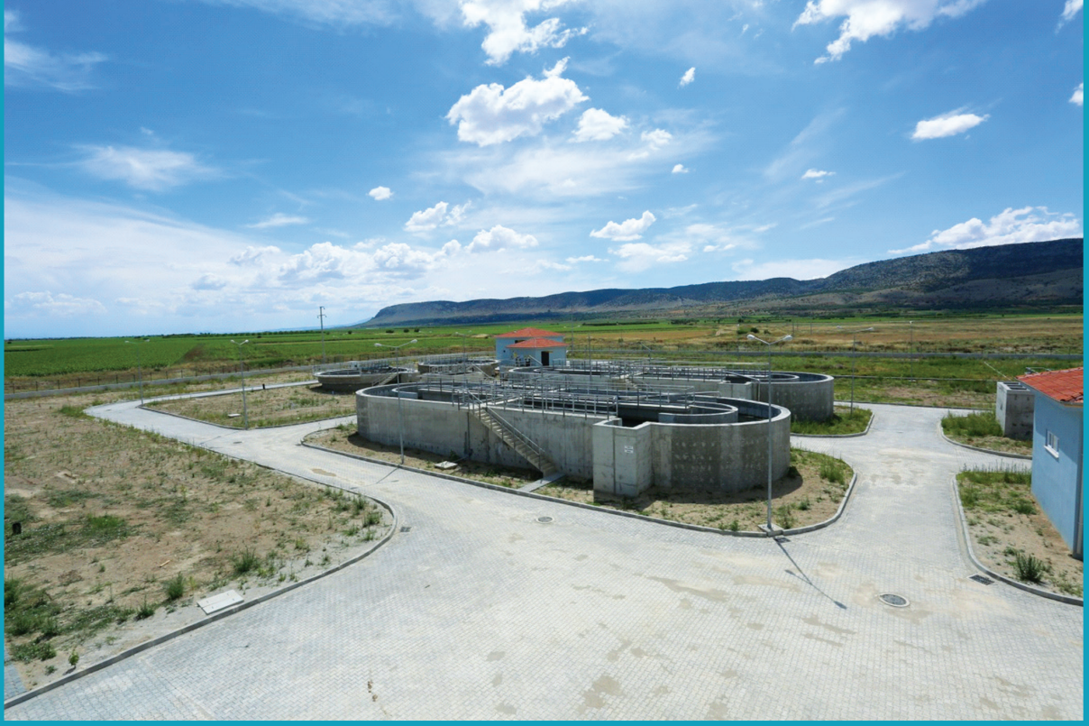
Çivril Atıksu Arıtma Tesisi
