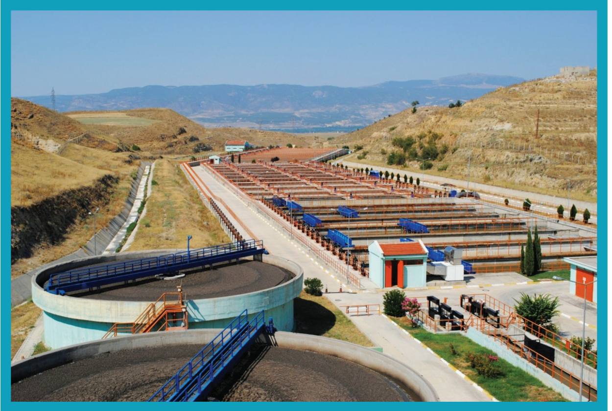
Merkez Atıksu Arıtma Tesisi
