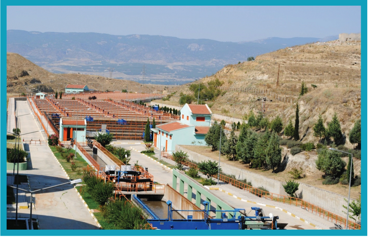
Merkez Atıksu Arıtma Tesisi
