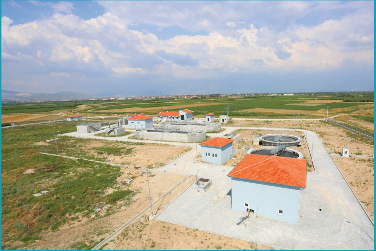
Çivril Atıksu Arıtma Tesisi
