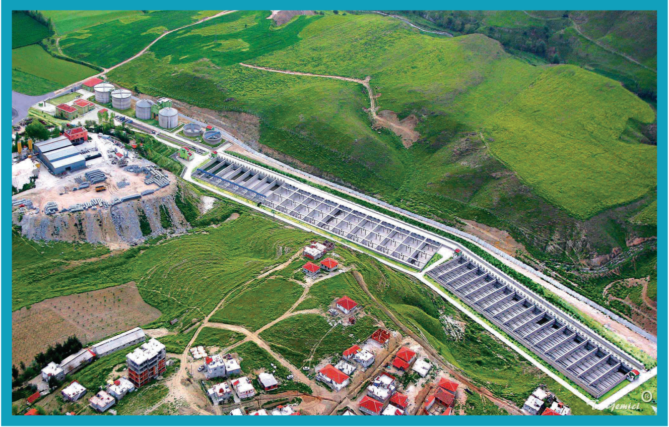
Merkez Atıksu Arıtma Tesisi
