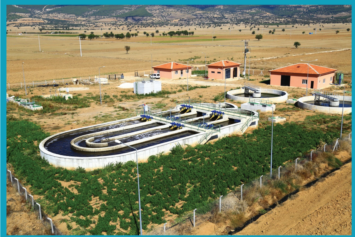
Serinhisar Atıksu Arıtma Tesisi
