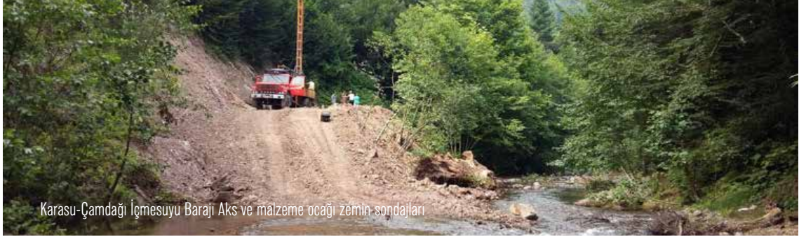
Karasu-Darıçayır içmesuyu baraj ön etüt zemin sondaj çalışmaları
