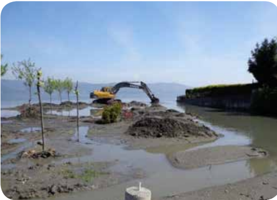
Yapılan dere temizlik çalışmaları
