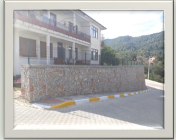
SUADIYE MAHALLESİ TAŞ DUVAR YAPIMI
