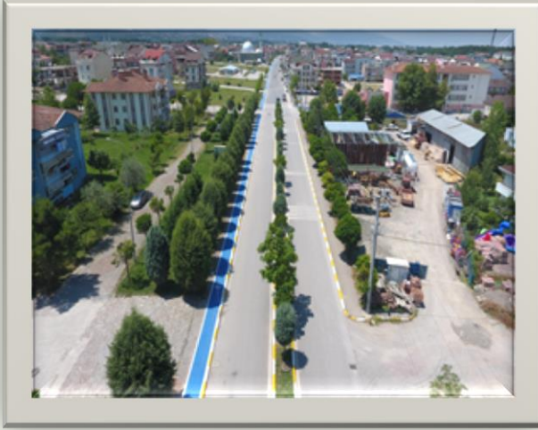
KÖSEKÖY MAHALLESİ BİSİKLET YOLU YAPIMI
