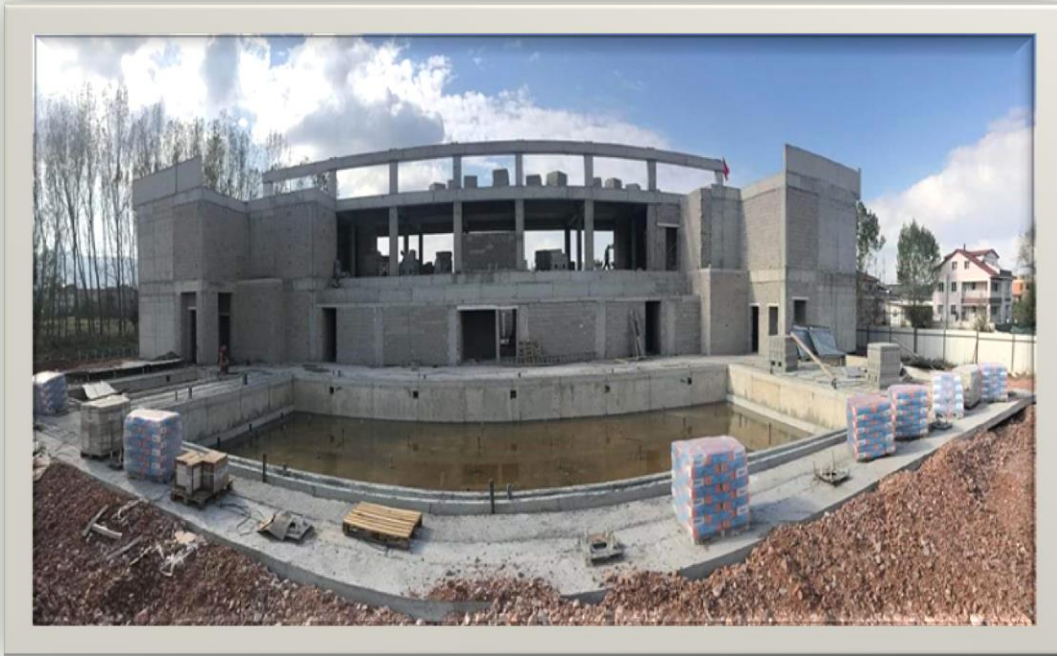
KÖSEKÖY KAPALI YÜZME HAVUZU YAPIM İŞİ
