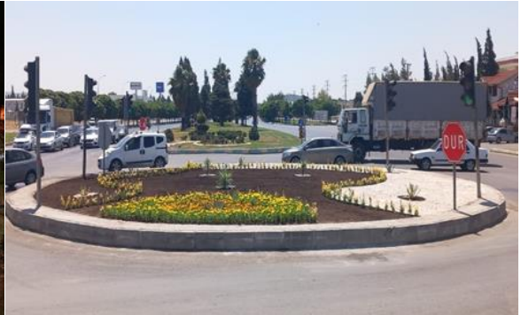
Havaalanı Kavşağı Yenileme Çalışması
