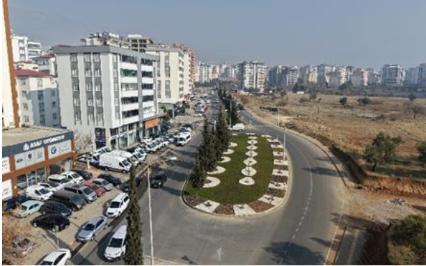
Adil Erdem Beyazıt Bulvarı Refüj ve Kavşak Düzenleme Çalışması
