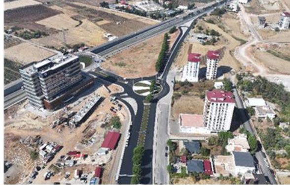
Prof. Dr. Necmettin Erbakan Bulvarı Kayseri Yolu Kesişimi Refüj ve Kavşak Düzenleme Çalışması
