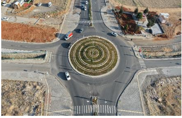
Turgut Özal Bulvarı Kavşak Yenileme Çalışması
