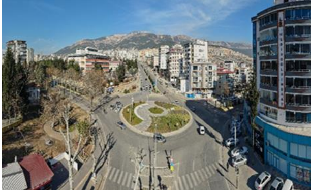
Kadir Paşa Bulvarı-Necip Fazıl Kısakürek Bulvarı Kesişimi Kavşak Düzenleme Çalışması
