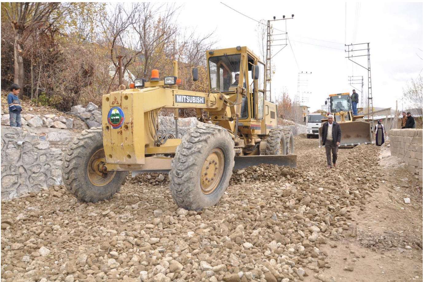
2015 Yol yapım işleri
