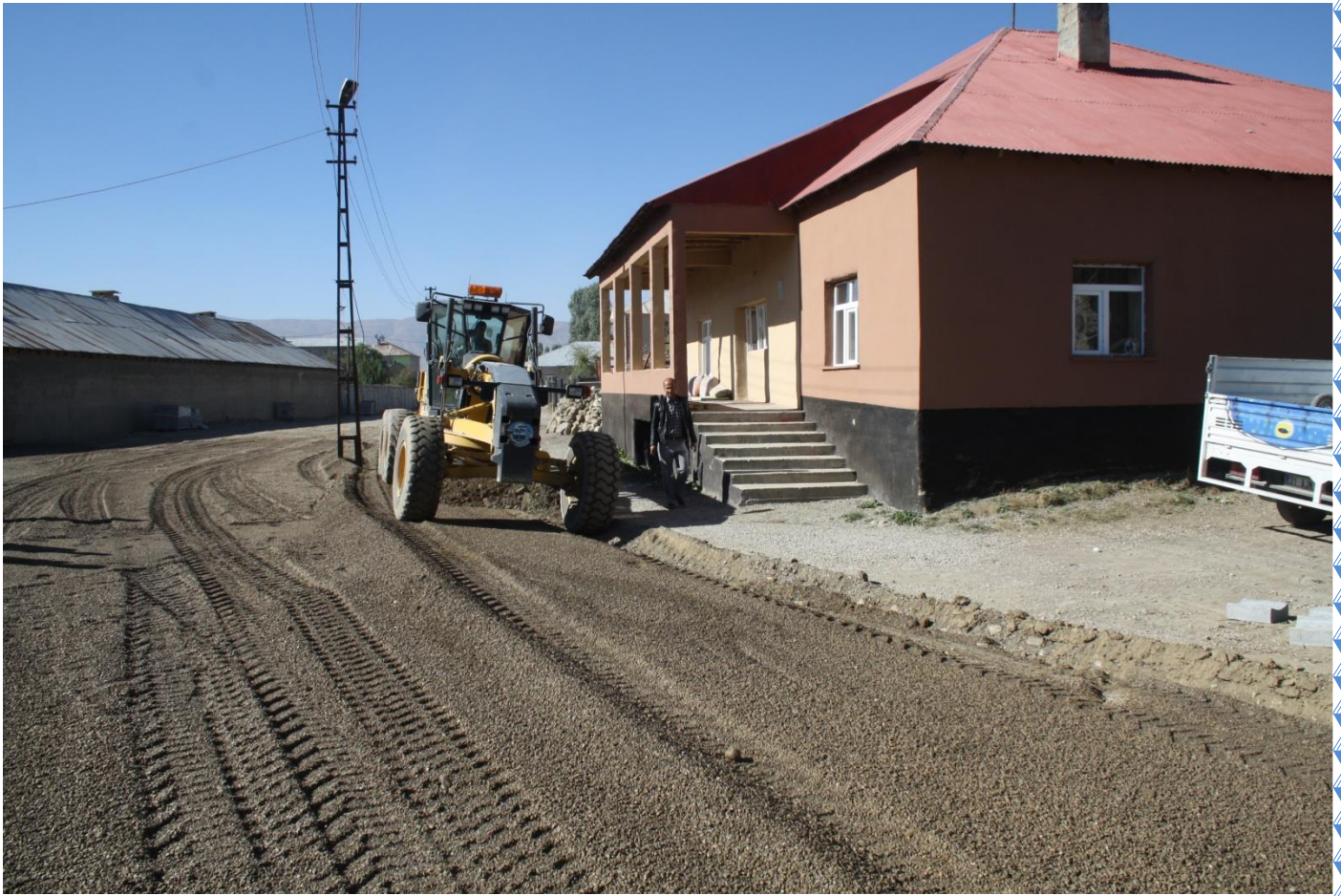
2015 Yol yapım işleri
