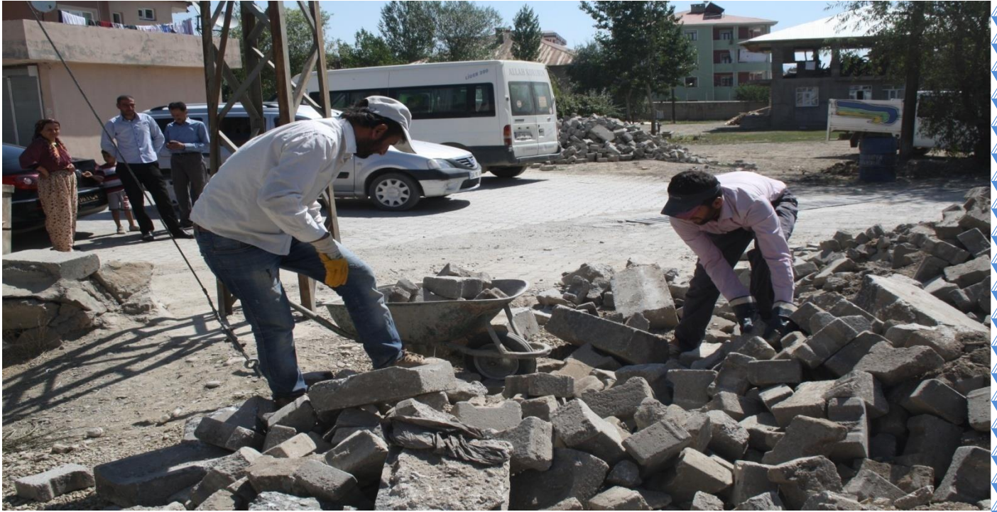
2015 Yol yapım işleri
