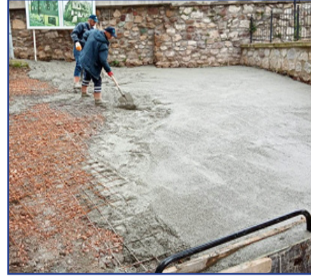
HACIHASAN MAH. BETON YOL TAMİRİ
