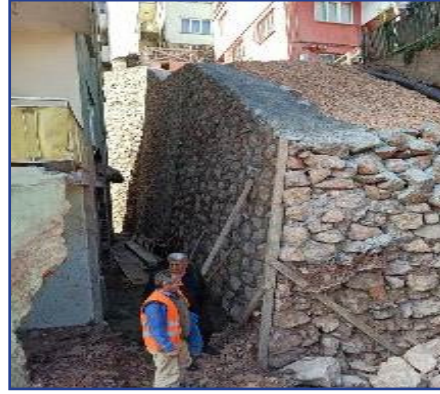
SERDAR MAHALLESİ GİRGİN SOKAK
