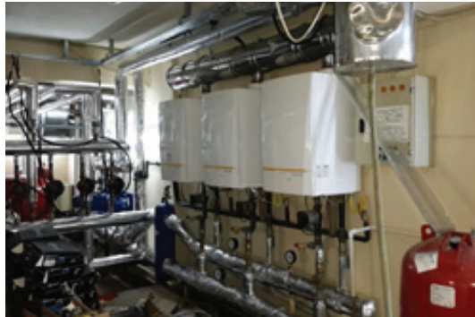
Yoğunmalı kazanlar ile enerji verimimiz daha da artmıştır
