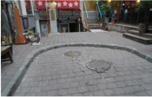
Caferağa Mahallesi, Mimar Çıkmazı Sokak'ta yaptığımız yeni baskılı asfalt uygulaması
