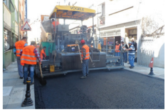
Hasanpaşa Mahallesi, Nabizade Sokak'ta müdürlüğümüzce yaptırılan asfalt serimi
