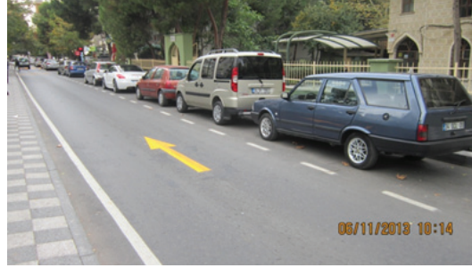
Kaldırımları, asfaltı ve yol çizgileri yenilenen Tüccarbaşı Sk. (19 Mayıs Mahallesi)
