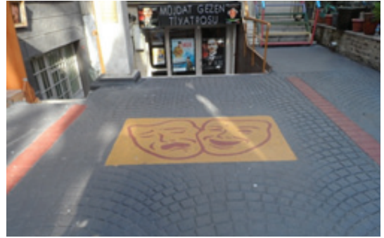
Caferağa Mahallesi, Mimar Çıkmazı Sokak'ta yaptığımız yeni baskılı asfalt uygulaması
