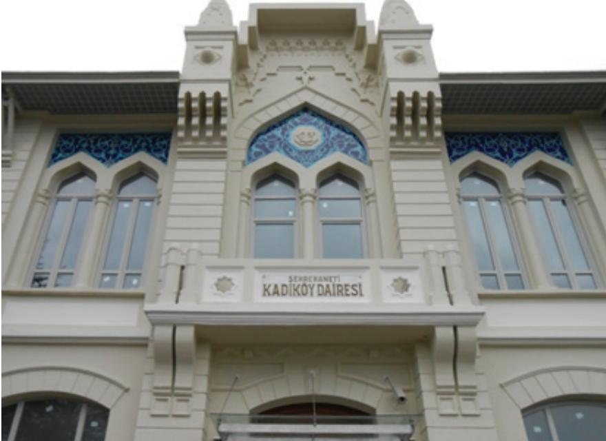
2013 yılında Rıhtım Caddesi üzerindeki Şehremaneti binamızın restorasyonunu gerçekleştirdik. Binamızın tarih, edebiyat ve sanat kütüphanesi olarak düzenlenmesi devam etmektedir.
