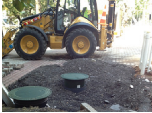
Gri Su tankerleri (solda) ve yağmur suyu tankerleri, montajdan hemen sonra (sağda)
