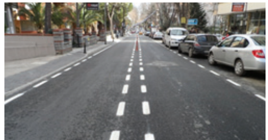
Suadiye Mahallesi Emin Ali Paşa Caddesi'nin bir bölümünde bulunan havai hatların Ayedaş tarafından yer altına alınması temin edildikten sonra kaldırımlar ve asfalt yenilenmiştir.
