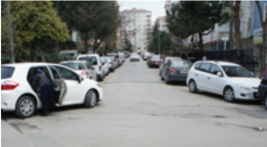
19 Mayıs Mahallesi Rıfkı Bey Sokak, eski hali (solda) ve yeni hali (sağda) Sokağımızın asfalt kaplaması ve kaldırımları yenilenerek, çalışma yatay ve düşey işaretlendirmeler ile tamamlanmıştır.
