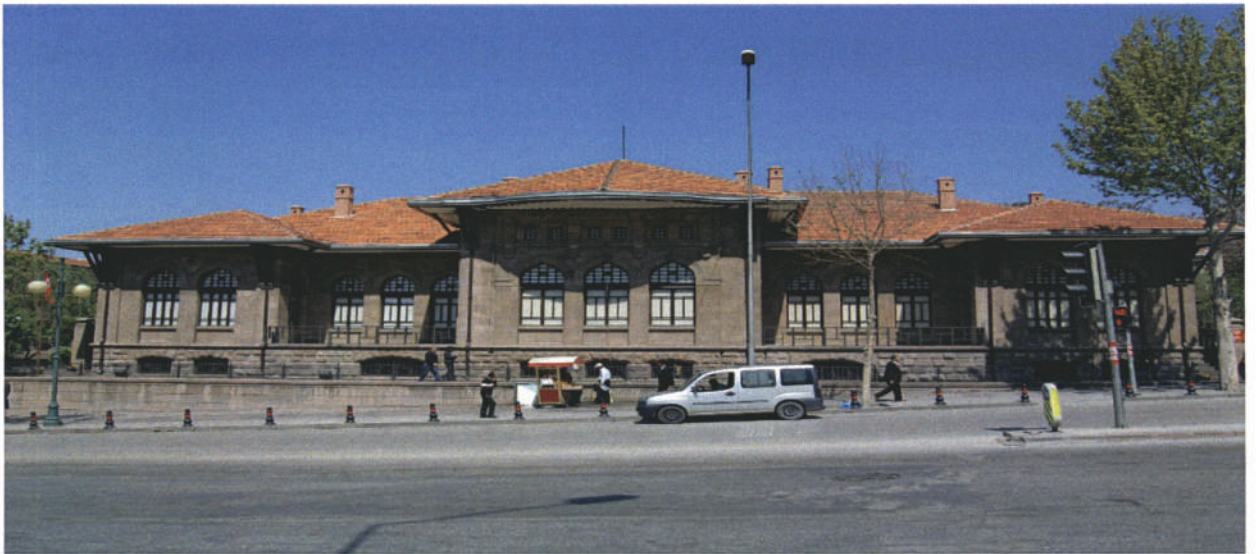
1.Meclis Binasının önden görünüşü
