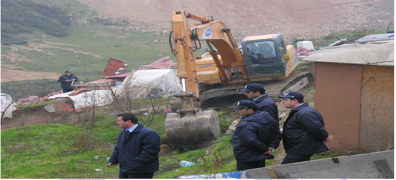
Gece Kondu Yıkımı
