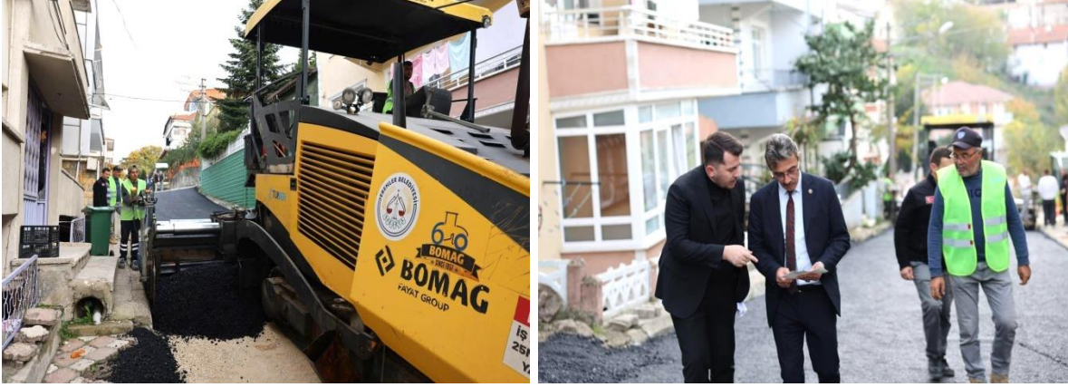
Bağlar Mahallesi Asfalt Çalışmaları
