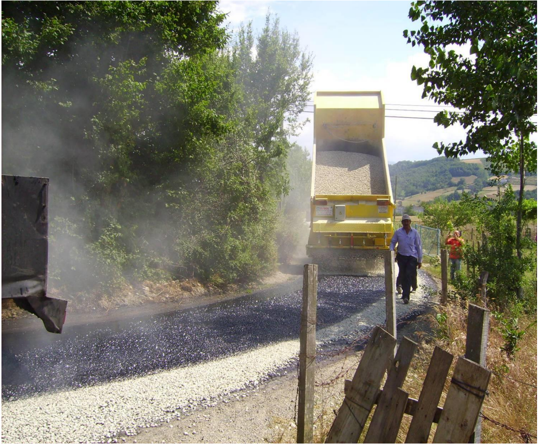
YOL AÇILMASI VE ASFALT KAPLAMA ÇALIŞMALARINDAN GÖRÜNTÜLER
