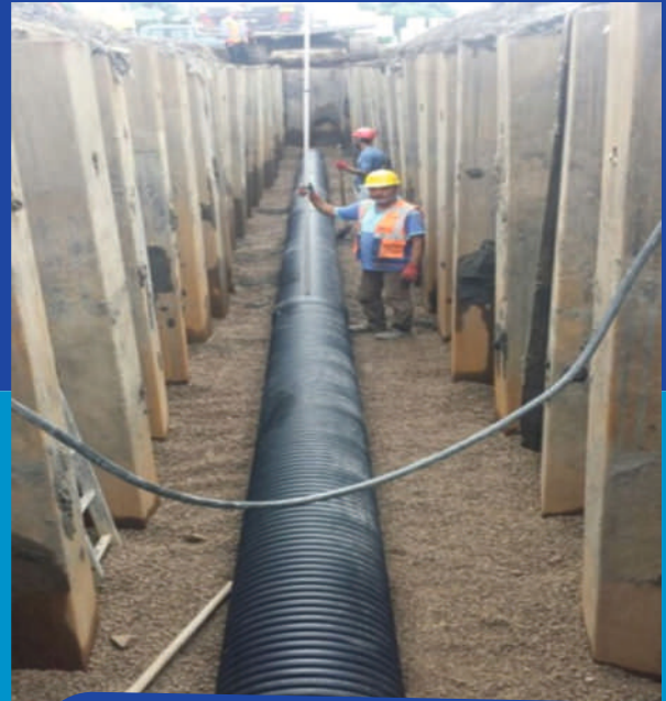
Palplanşlı Kanalizasyon Çalışması
