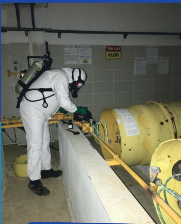
İÇME SUYU ARITMA TESİSLERİ KLOR ÜNİTESİ BAKIMI
