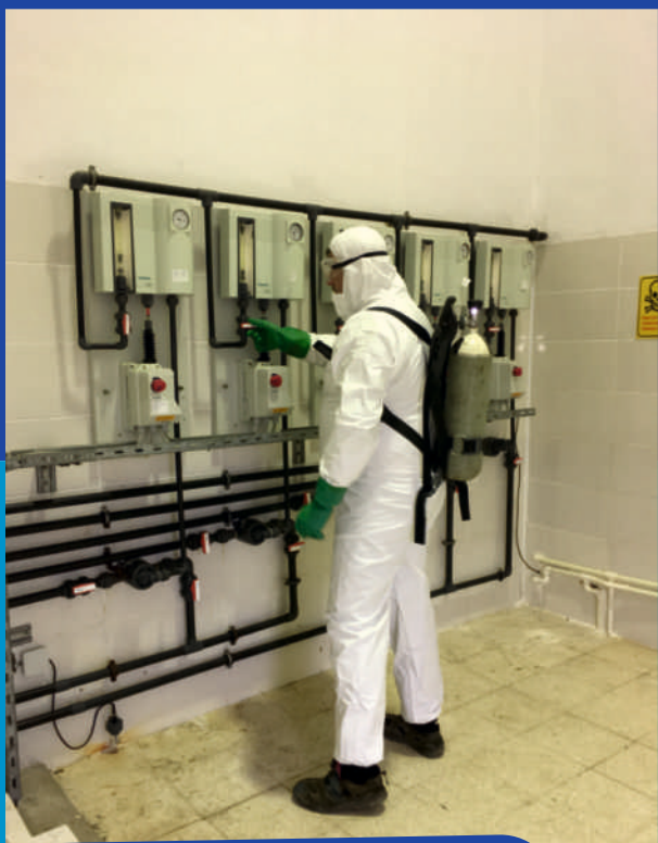
İÇME SUYU ARITMA TESİSLERİ KLOR ÜNİTESİ BAKIMI
