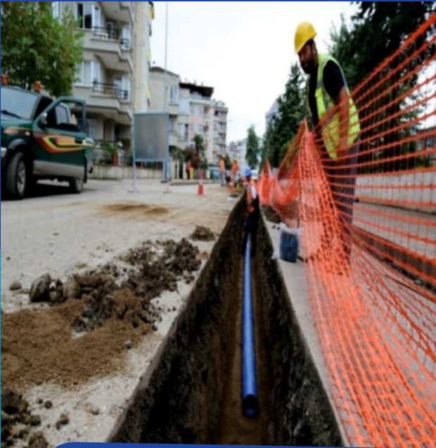
İçme Suyu Çalışması
