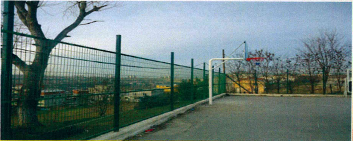
ÇATALARMUT İLKOKULU ETRATI TELÖRGÜ YAPIMI
