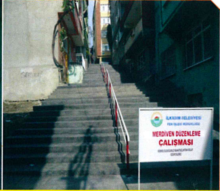
ZEYTİNLİK MH. 132 SK. BASKI BETON MERDİVEN YAPIMI.
