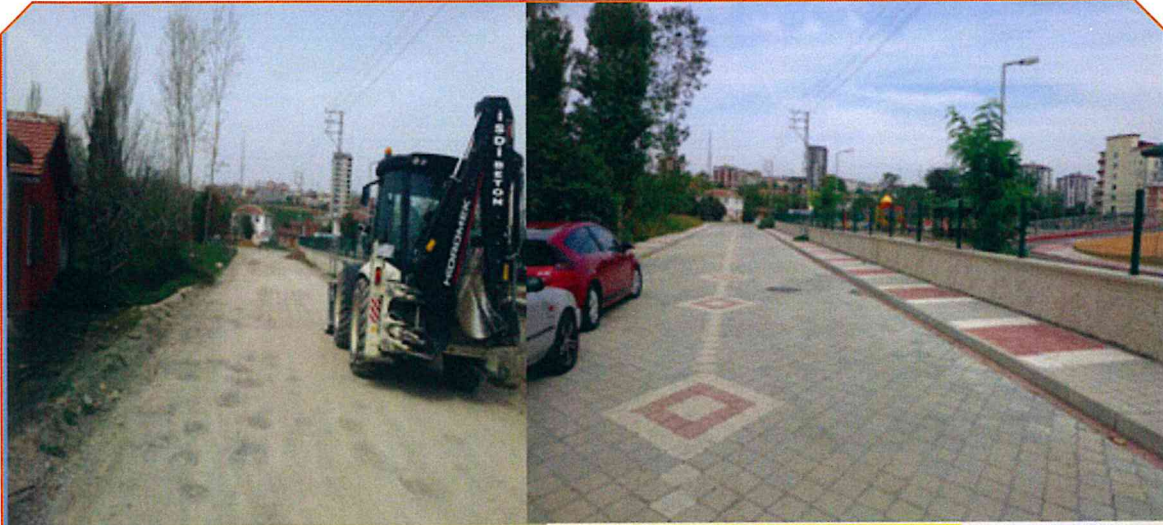
DEREBAĞÇE MH. 6. SK.
