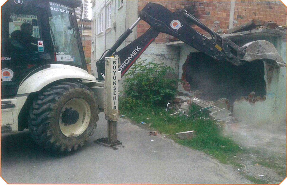
Adalet mahallesi Maili İnhidam kararı ile yıkımı gerçekleştirilmiş metruk bina
