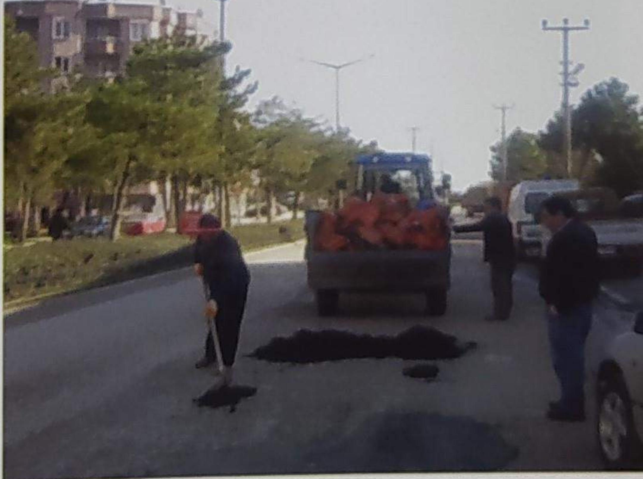
Soğuk asfalt kaplama çalışması
