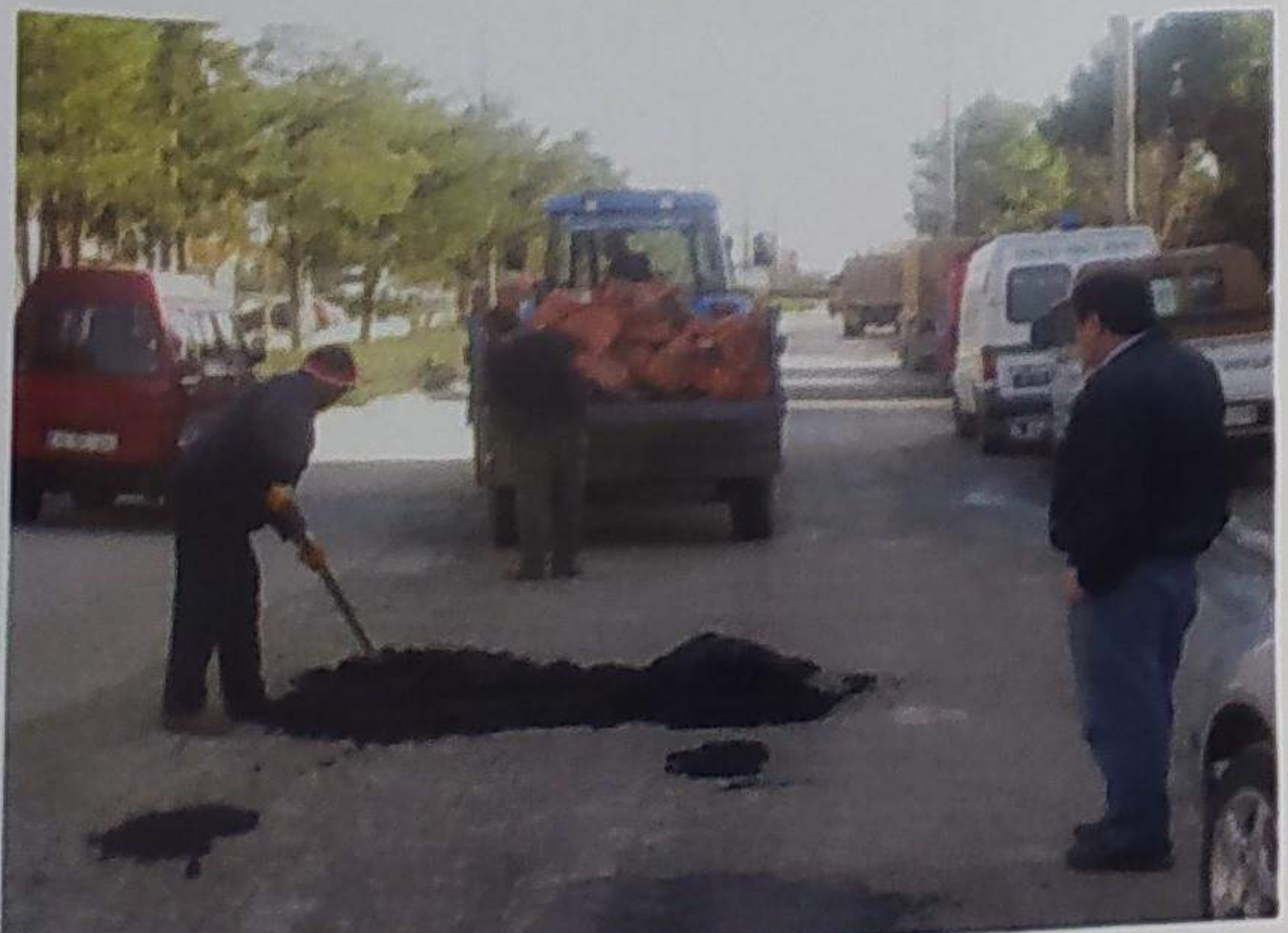
Soğuk asfalt kaplama çalışması
