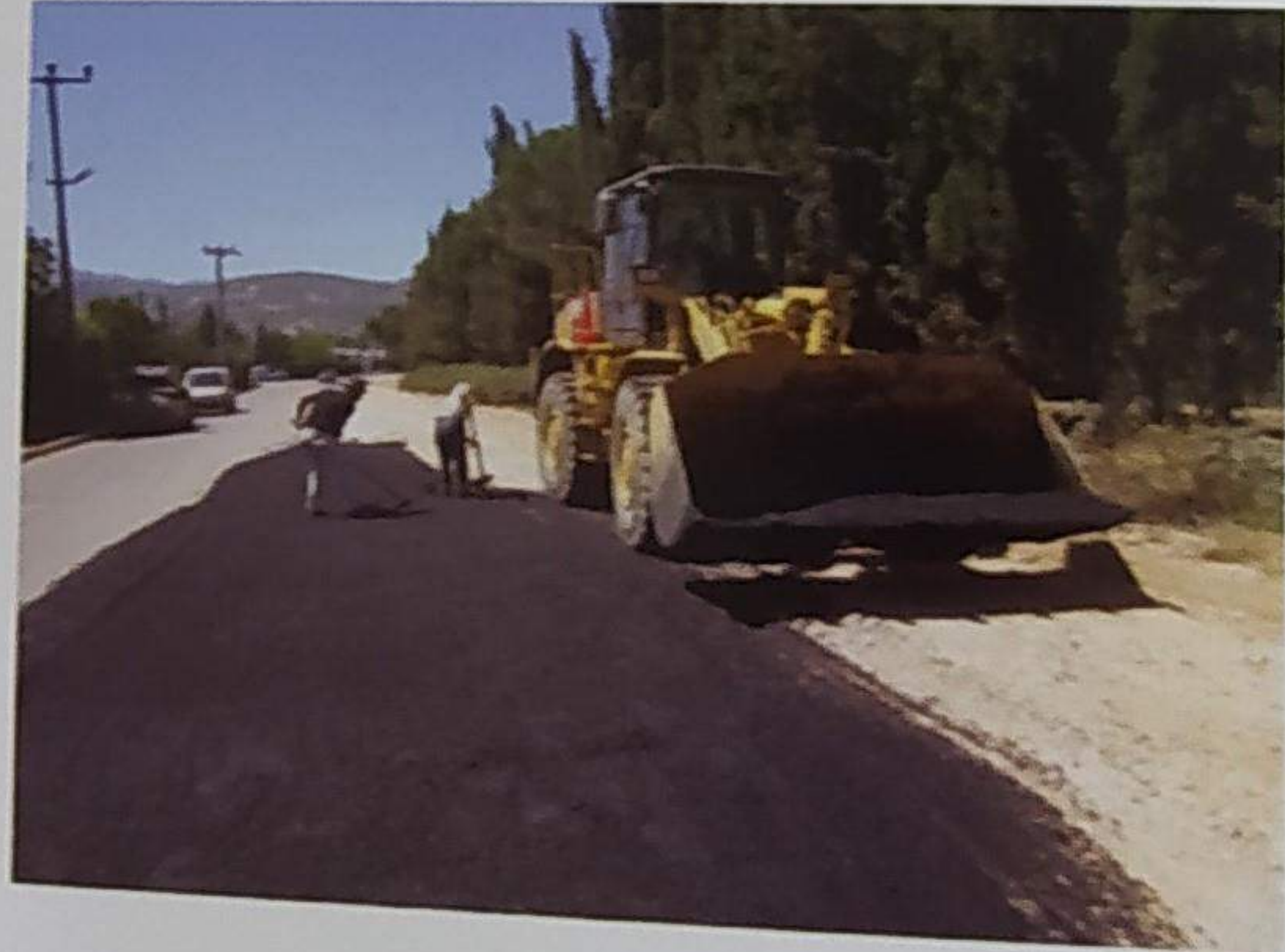
Sıcak asfalt kaplama çalışması
