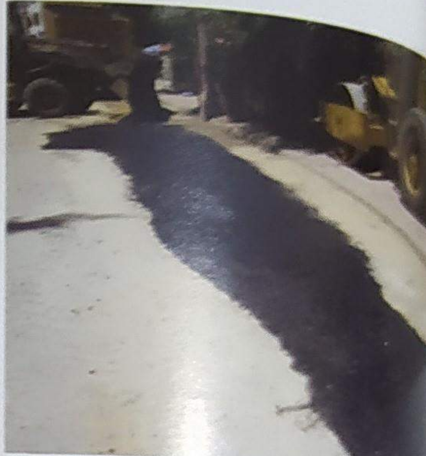
Sıcak asfalt kaplama çalışması
