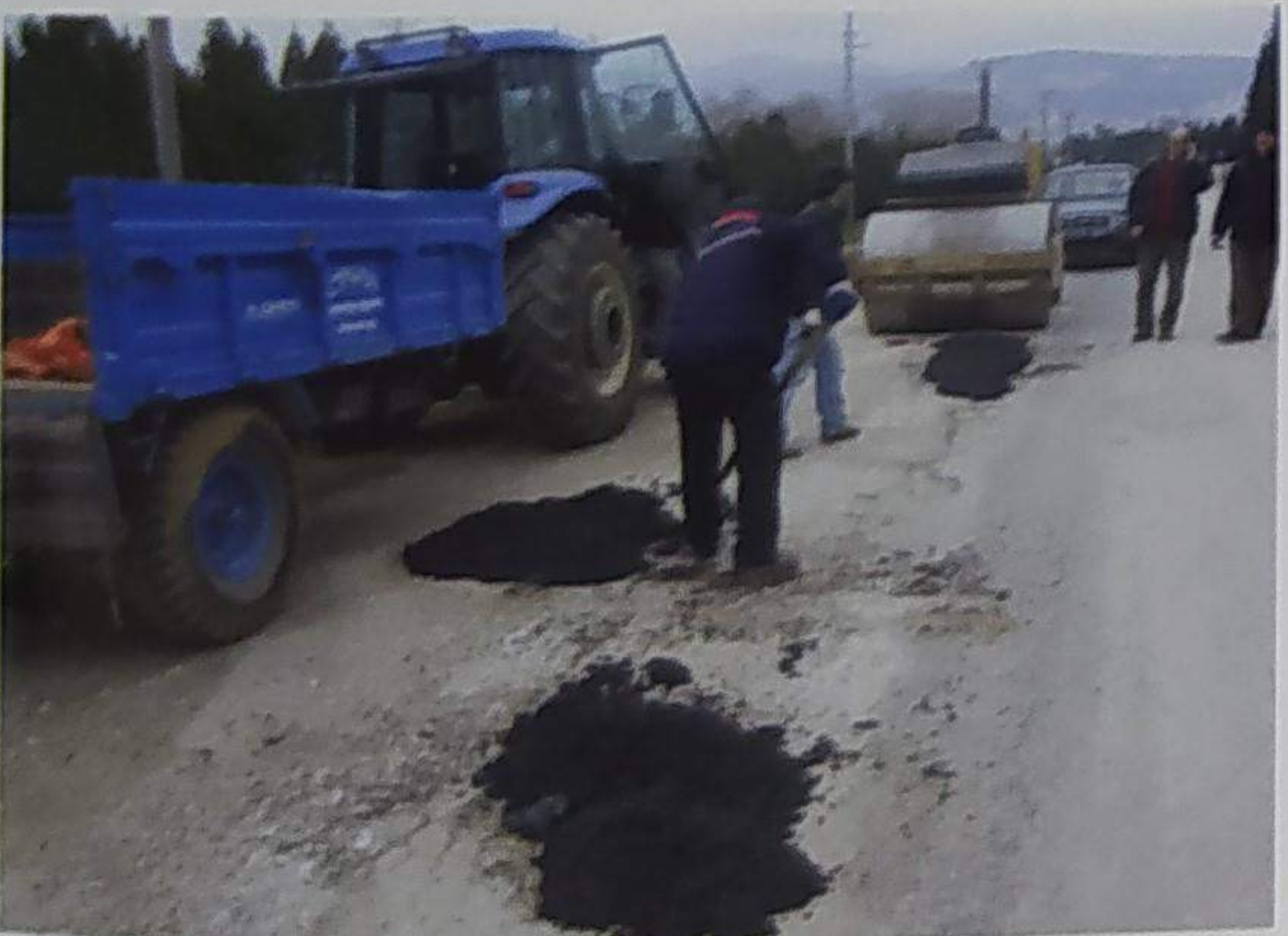
Soğuk asfalt kaplama çalışması
