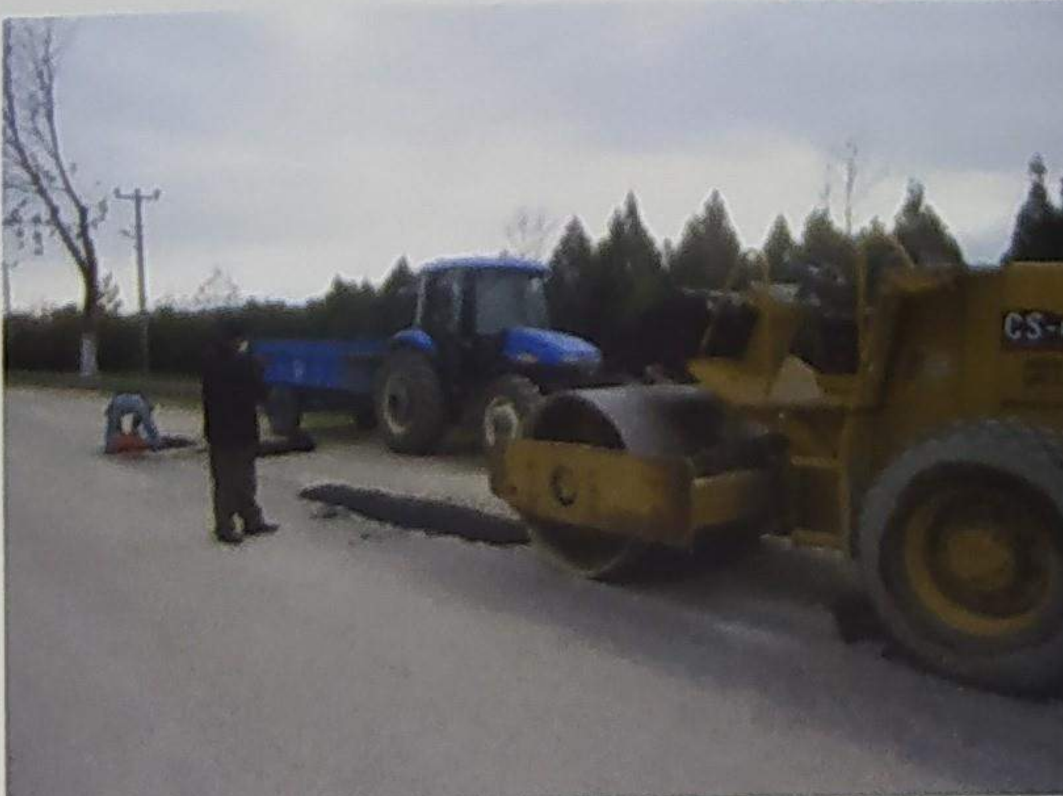
Soğuk asfalt kaplama çalışması
