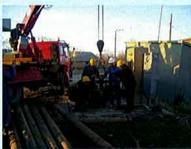
Pompa Montaj Çalışması (Kaş 6 Kuyusu)
