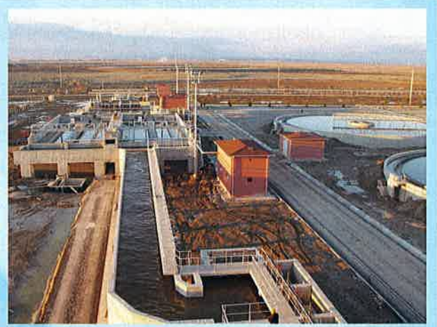
Kum-Yağ Tutucu-Ön Çökeltme
