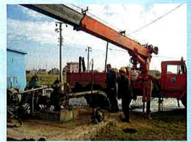
Pompa Test Çalışması
