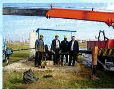
Test Pompası Kurulum Çalışması
