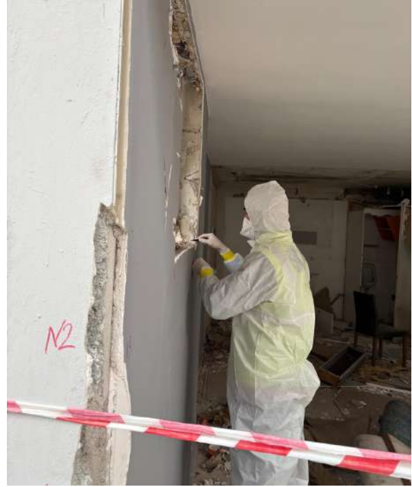
Asbest Numune Alımı
