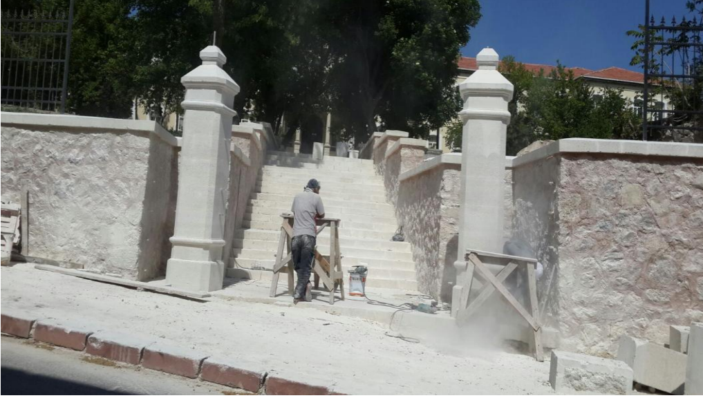
Makedonya Yerleşkesi Çevre Duvarı II. Etap Onarım
