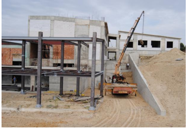
Teknik Bilimler MYO Binaları Altyapı ve Çevre Düzenlemesi
