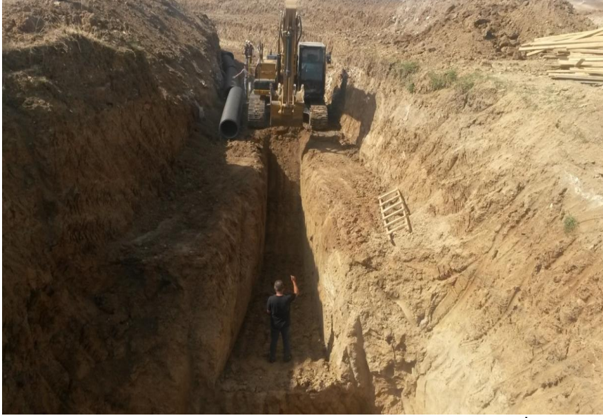
Balkan Yerleşkesi Alternatif Kanalizasyon Hattı ve Galeri İlavesi
