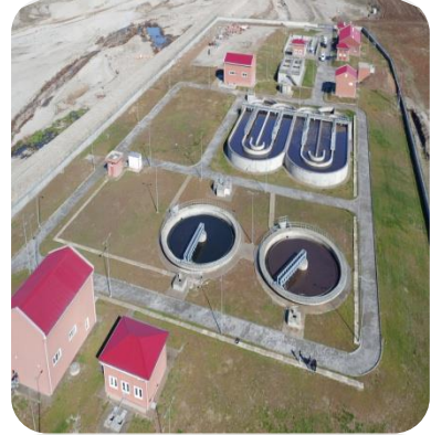
Türkoğlu Atıksu Arıtma Tesisis
