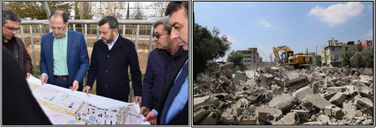
Resim 99: Kentsel Dönüşüm Çalışmaları
