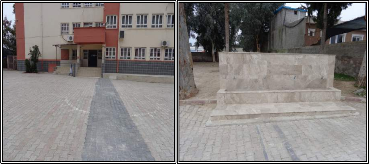
Resim 118: Okul Bakım, Onarım ve Donatı İşleri
