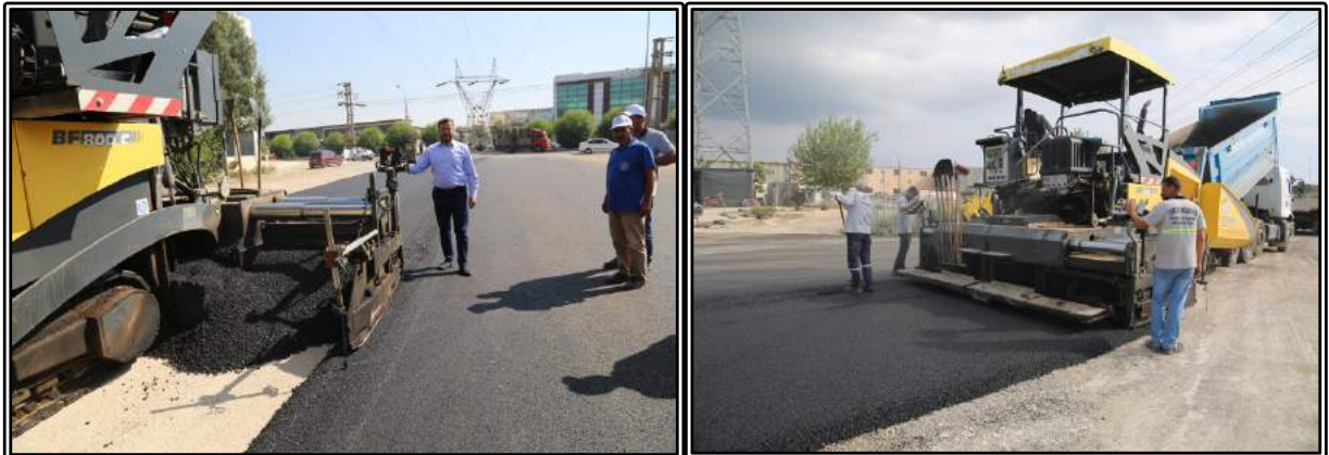
Resim 102: Asfalt Kaplama Çalışmaları
