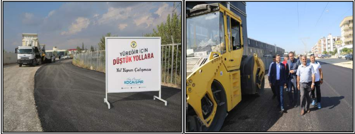
Resim 101: Asfalt Kaplama Çalışmaları
