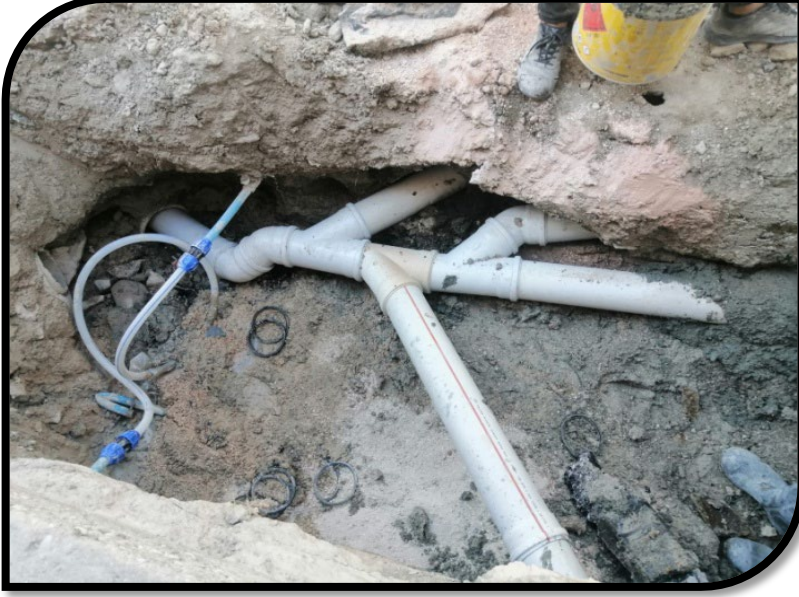
Kanalizasyon baca kurulumu
