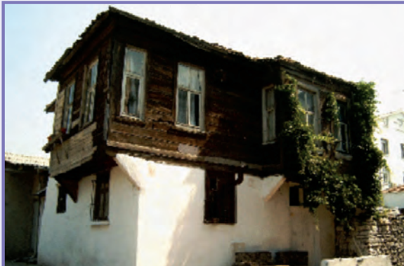
Merkezefendi Mah. 2932 Ada 3 Parsel Ahşap Konak Restorasyon Yapım işi
