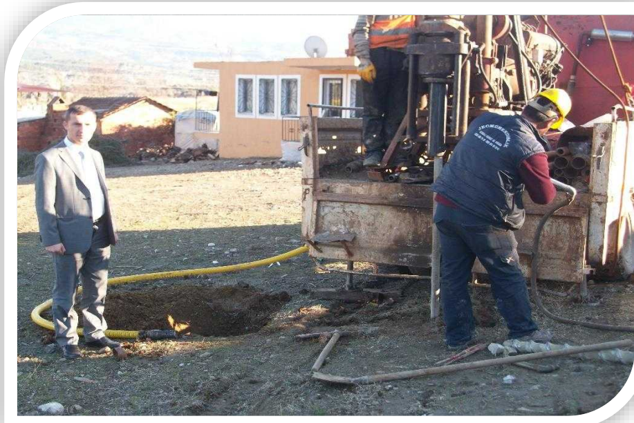
Foto 10. Zemin Etütlerinin Yerinde Kontrolleri Yapılırken
