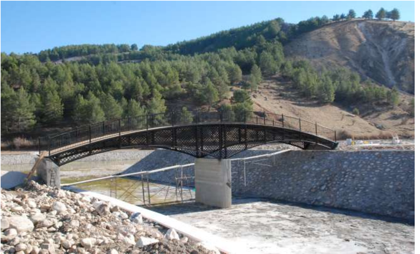
Beşınar Vadisi Rekreasyon Projesi – Sosyal Tesisleri–Kanal ve Yaya Köprü
