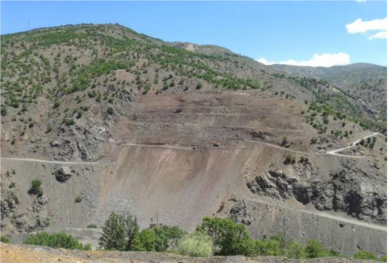
Sincik İlçesi Yeni Yol Açılması Çalışmaları
