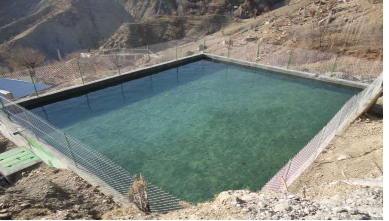
Sincik Hüseyinli Köyü Karamanlar Mezrası Tarımsal Sulama Tesisi
