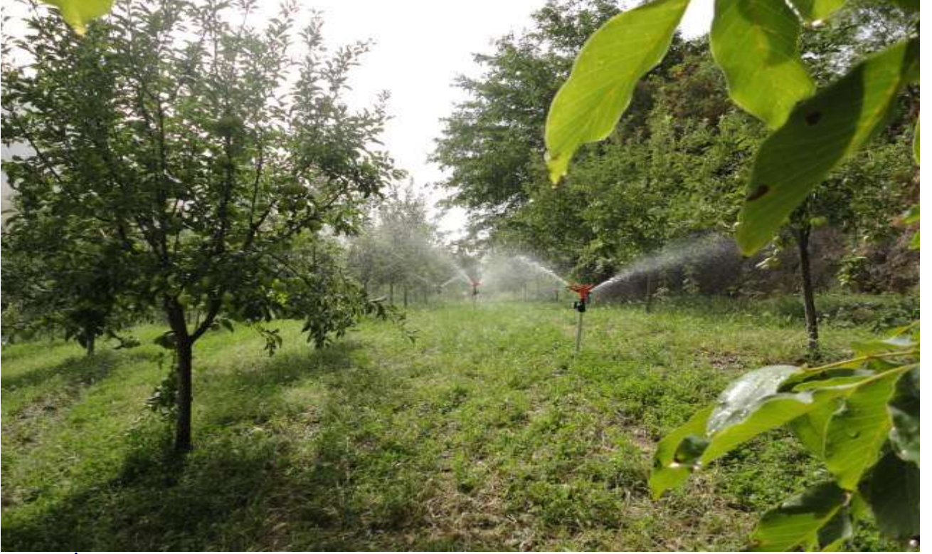
Çelikhan İzci Köyü Tarımsal Sulama Tesisi
