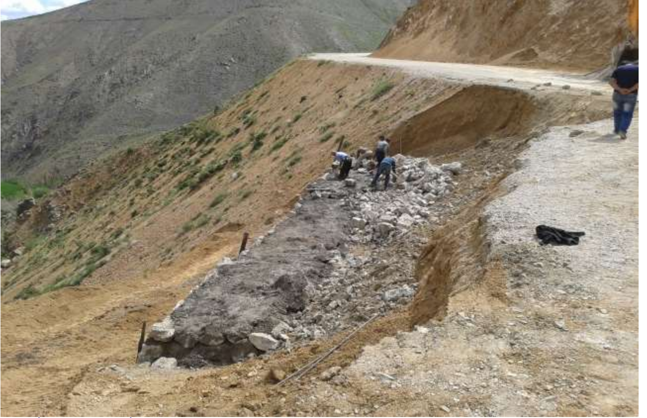
Sincik İlçesi Köy Yolları İhata Duvar Yapımı
