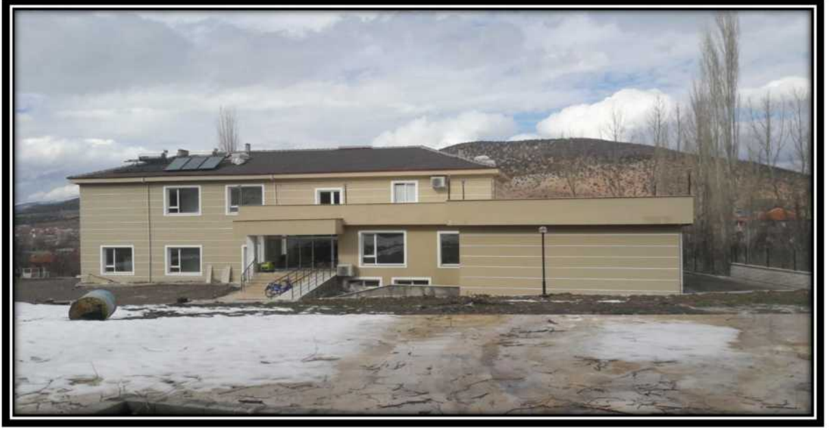
Foto-10: Kültür ve Eğitim Kompleksi Binasından Görünüm
