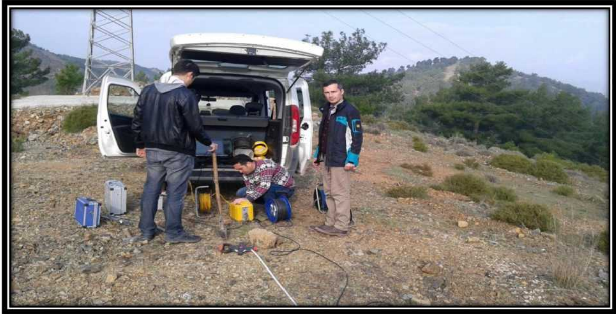
Foto-1: Engelsiz Yaşam Merkezi Yerine Ait Plana Esas Jeolojik ve Jeoteknik Etüt Çalışmalarından Bir Görünüm
