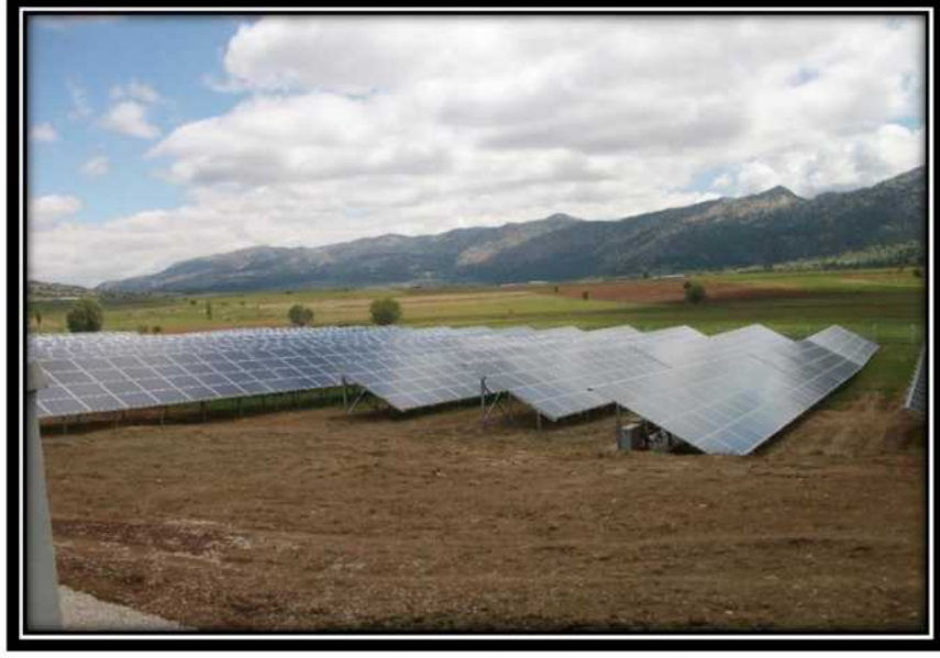
Foto-2: Güneş Enerji Santrali
