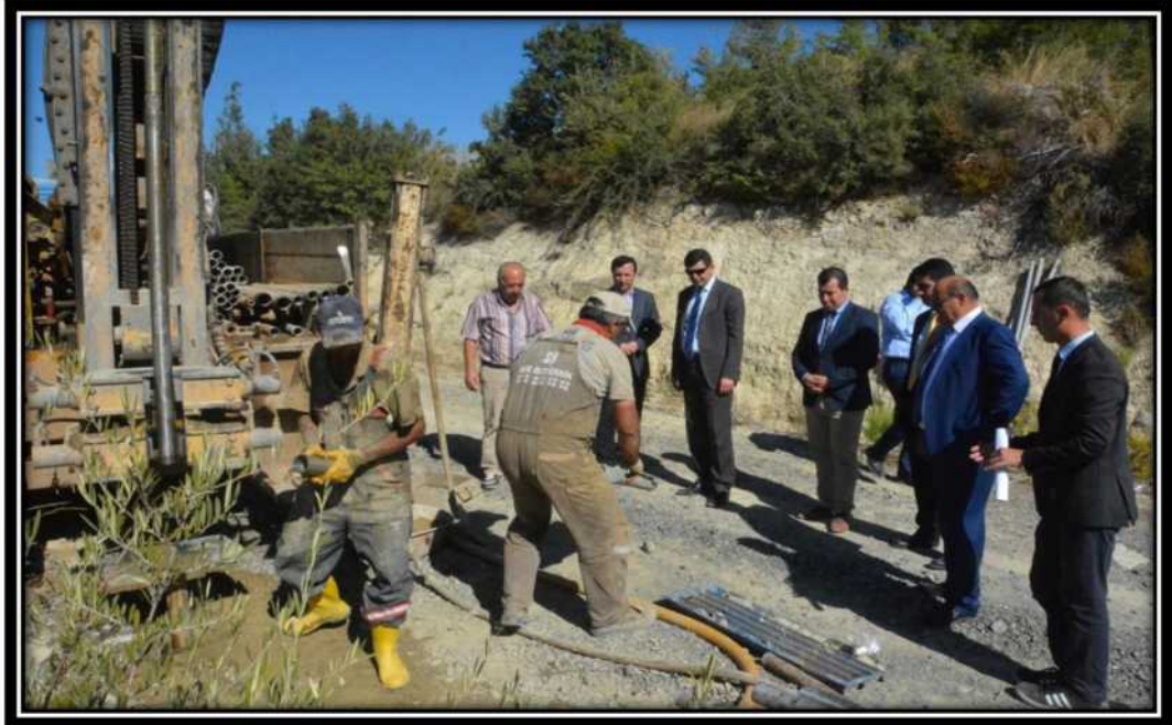
Foto-8: Sondaj Çalışmaları Yerinde İncelenirken
