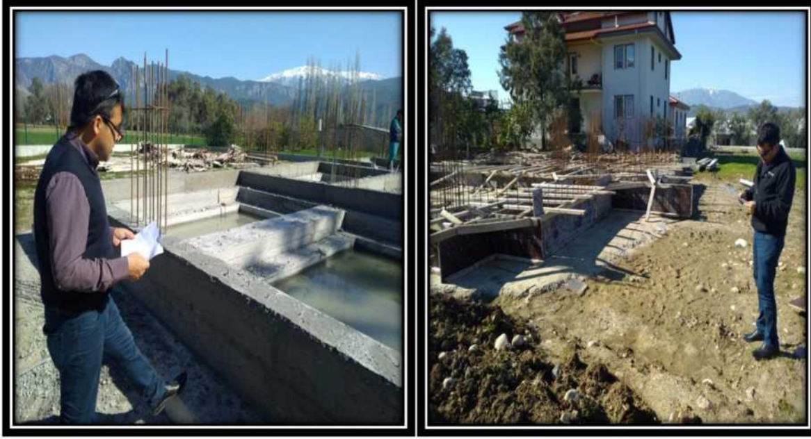
Foto-8: Subasman Kontrollerinden Bir Görünüm
