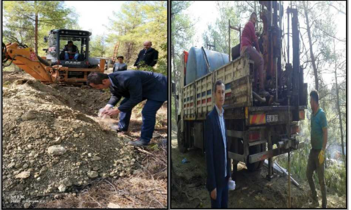
Foto-4: Hastane Yeri Zemin Etüt Çalışmalarından Bir Görünüm
