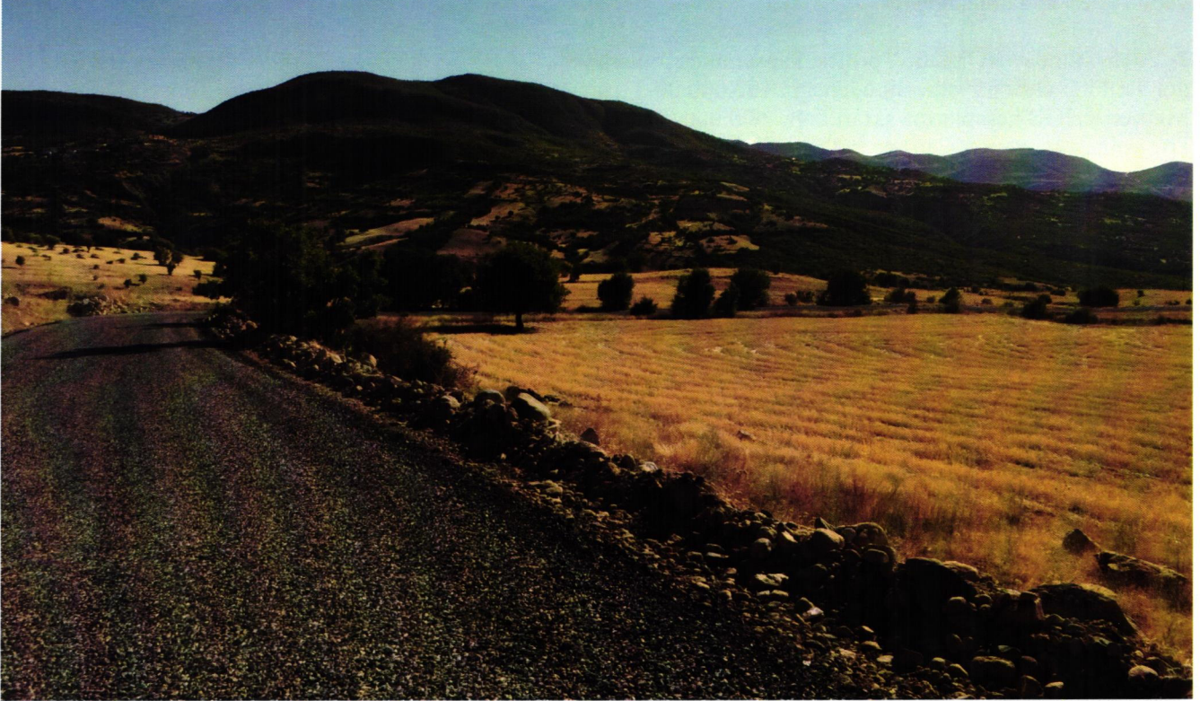
Kayırlar köyü köy yolu stabilizesi yapım işi
