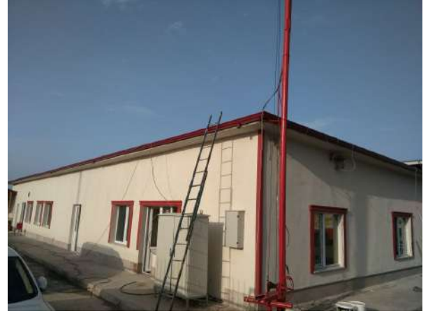
Maçka İtfaiye binası çatı tadilatı yapıldı.
