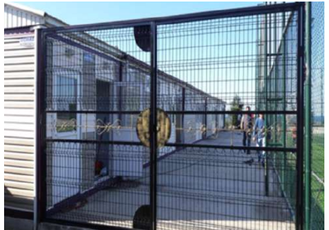
Spor sahası güvenliği için girişine ferforje korkuluk ve kapı yapılmıştır
