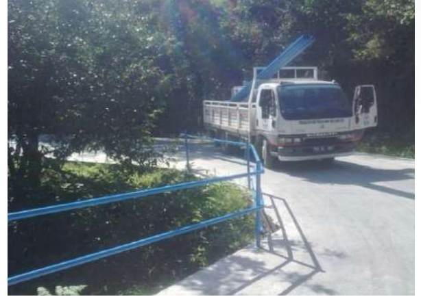
Muhtelif ilçelerde korkuluk yapılması,tamiri ve boyanması
