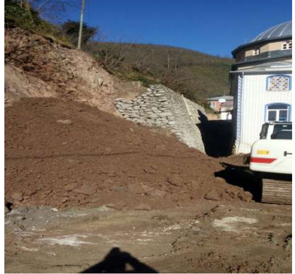
Ortahisar İlçesi Pınaraltı camii
