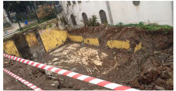
Ortahisar İlçesi, Bahçecik Mahallesi 1000kVA Trafo Köşkü Yapımı devamETMEKTEDİR. Sözleşme bedeli:419.061,00-TL
