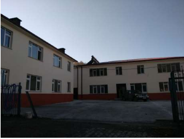
Of İlçesi, Bölümlü Mahallesi Kız Kuran Kursu tadilatı Ve Çevre Düzenlemesi tamamlandı. Sözleşme bedeli: 205.000,00-TL
