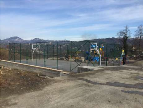
Of İlçesi Sarıkaya Mahallesi Park yapımı inşaatına 18/11/2016 tarihinde başlanmıştır. Yapımı devam etmektedir. Sözleşme bedeli:108.276,60-TL
