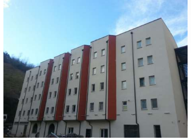
Maçka İlçesi, Konak Mahallesi Erkek Yatılı Kuran Kursu Binasının Tadilatı tamamlandı. Sözleşme bedeli: 645.161,08-TL
