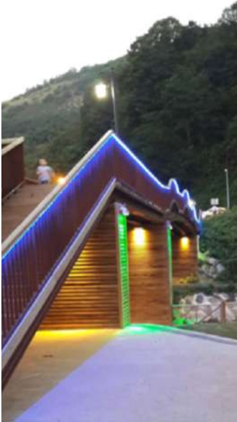
Sera gölündeki ahşap köprü'nün ve halka açık alanın ilave aydınlatılması yapılmıştır
