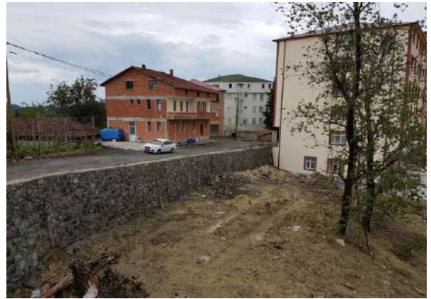
Arsin İlçesi, Çiçekli Mah. Kız Kuran Kursu Zemin Güçlendirme İnşaatı tamamlandı. Sözleşme bedeli: 341.291,00-TL
