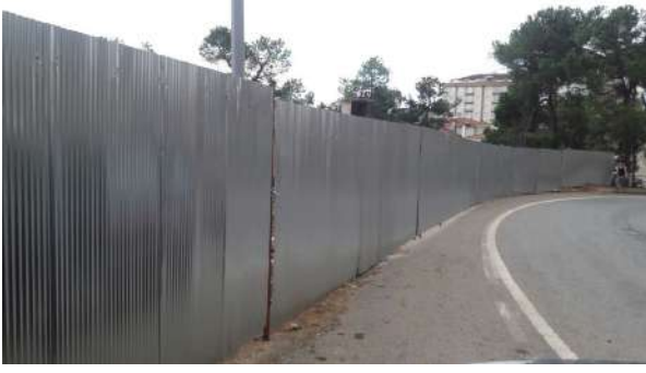
Belediyemiz tarafından yapılan inşaat sahalarının etrafı iş sağlığı ve iş güvenliği açısından koruma, altına alındığı bir çalışma
