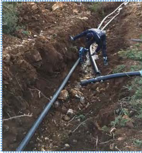
Ø110 mm PE100 Sondaj Kuyusu – Depo Arası Terfi-İsale Hattı Yapılması İşi
