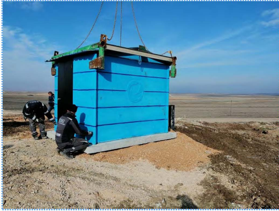
Su Sondaj Kuyu Binası Kurulması İşi
