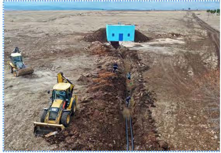
Terfi Hattı Kazı Çalışması
