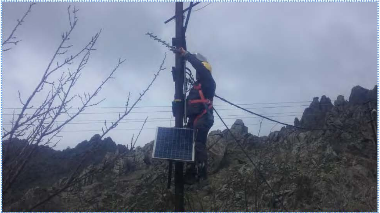
Anten Sistemi Kurulması İşi
