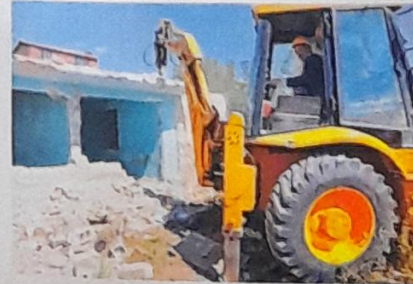
Kentsel Dönüşüm Yıkım Çalışmaları
