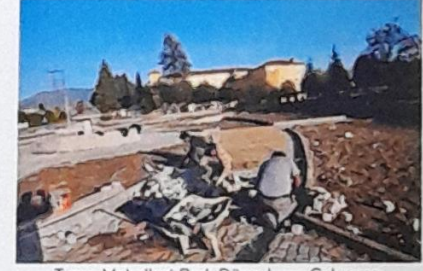
Turan Mahallesi Park Düzenleme Çalışması
