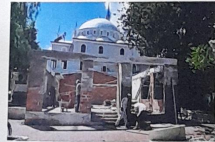
Yunus Emre Parkı Kapalı Alan İnşaatı
