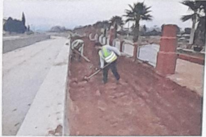
Dereköy çayı kenarı tesviye çalışması
