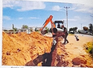
DKY. Kanalizasyon Hattı Döşeme Çalışması
