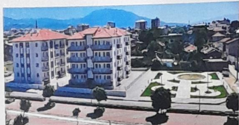
Kentsel Dönüşüm konutları güneyi parktan genel görünüm
