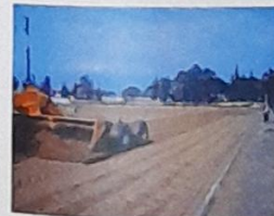
Sümer mahallesine 2 adet Futbol Sahasının yapım aşaması
