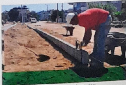
Bordür döşeme çalışmaları
