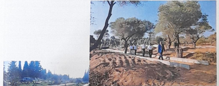
Eğriboyun mezarlığı doğu kısmında yapılmakta olan yeni bölümün tesviye çalışmaları devam etmektedir.
