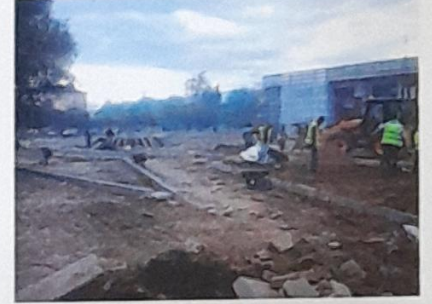
Turan parkının yapım aşaması
