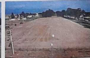
Sümer mahallesine yapılmış olan 2 adet çim futbol sahasının yapım aşaması (Çimlendirilmeden önceki hali)
