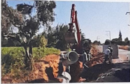
Dalıca – İsabeyli Yol ve Kanalizasyon Çalışması
