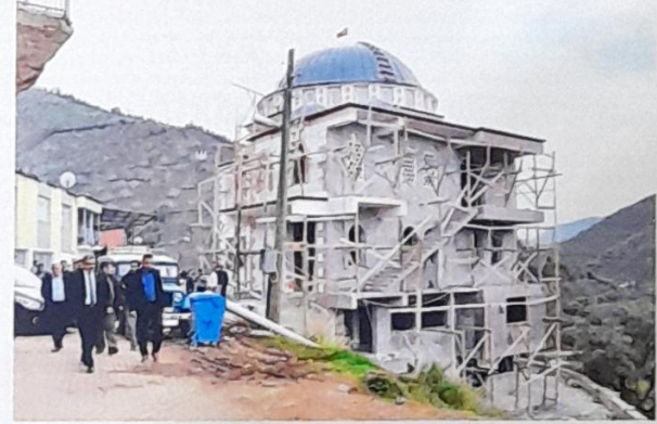
Bağcılı Mah. Camii inşaatı devam ediyor.
