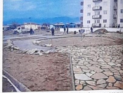
Kentsel Dönüşüm konutları güneyi park yapım aşaması
