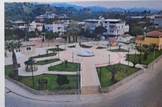
Dallica parkı tamamlanmış hali
