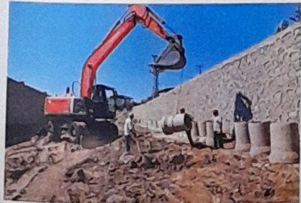
Dereköy Çayı İçi Kanalizasyon Çalışmaları
