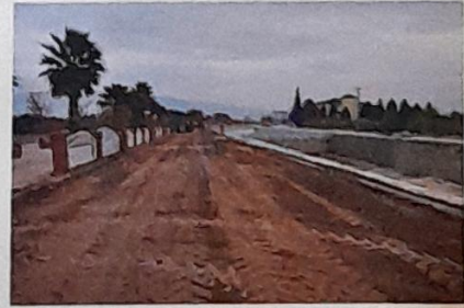
Dereköy Çayı, Yürüyüş ve Bisiklet yolu Çalışmaları
