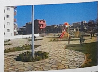
Kentsel Dönüşüm konutları güneyi parkından bir görünüm
