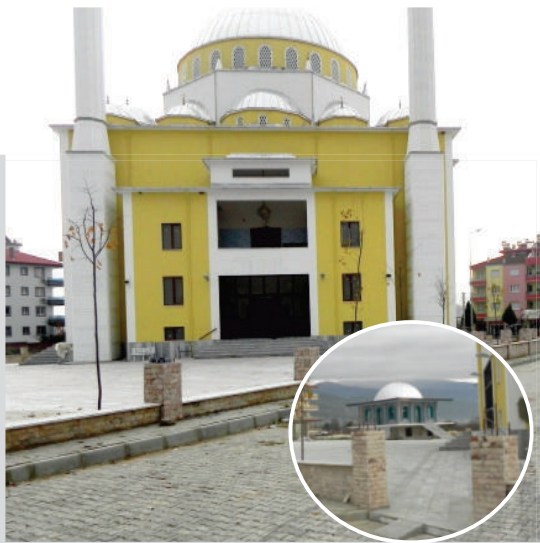
Şeker Camii Bahçe Genişletme Yapım Tarihi : 20.07.2013 - 21.08.2013 Harcama Bedeli : 72.500 TL
