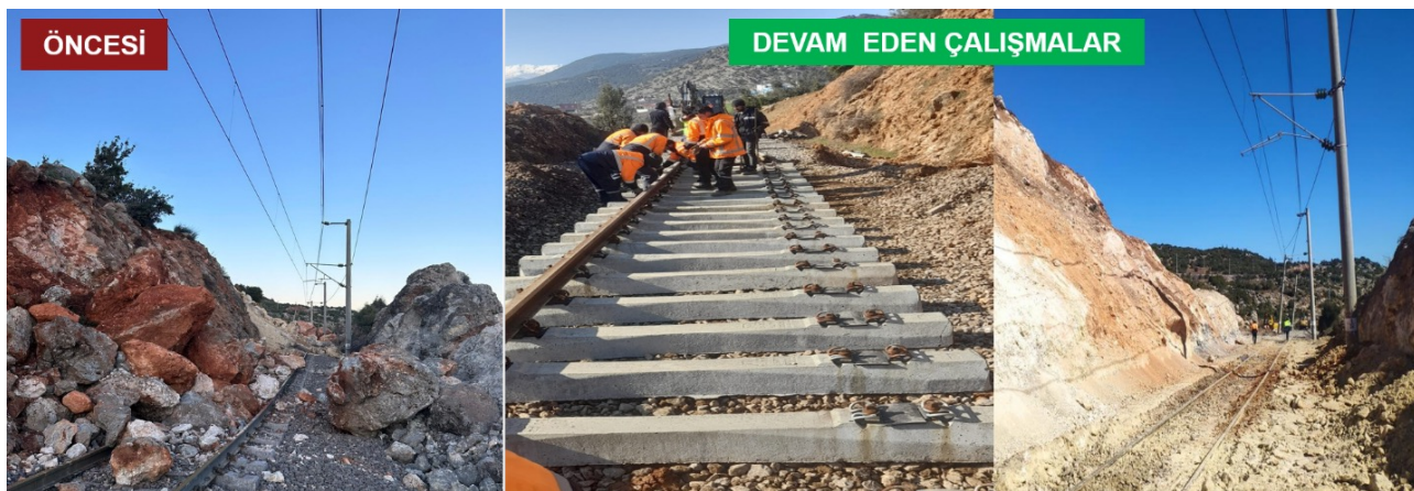
Fevzipaşa-Narlı Hat Kesimi (Km:0+500) Devam Eden Yapım Çalışmaları
