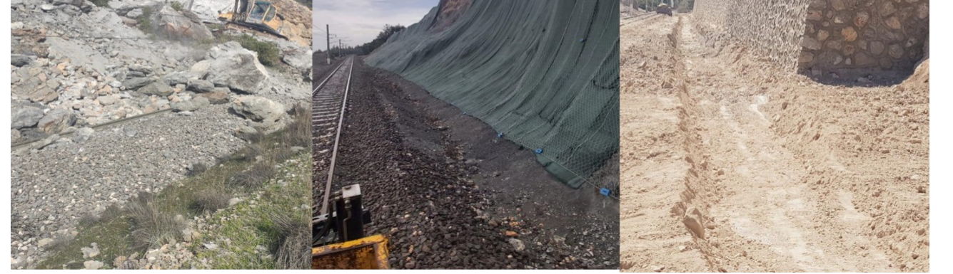
Fevzipaşa-Narlı Hat Kesimi (Km:2+500) Devam Eden Yapım Çalışmaları
