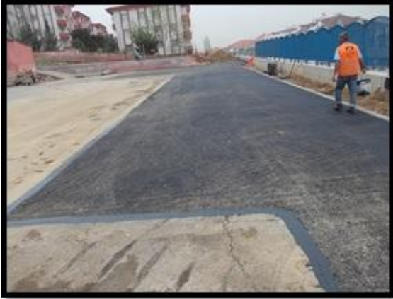
Asfalt Yama Çalışmaları
