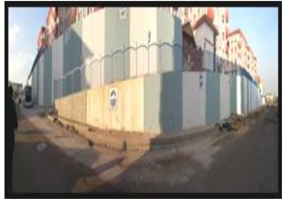
Duvar Yapım Çalışması
