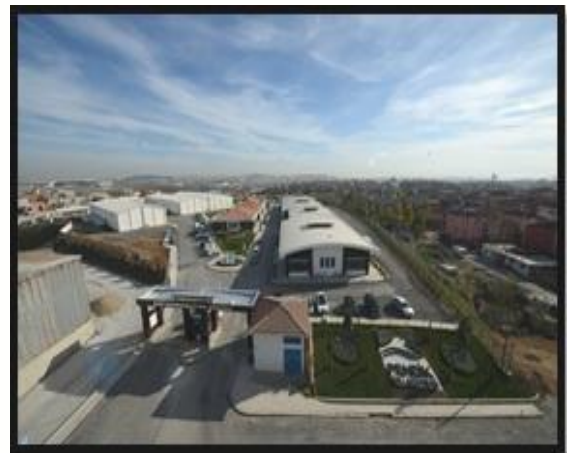
Güllübağlar Ek Hizmet Binası ve Afet Koordinasyon Merkezi
