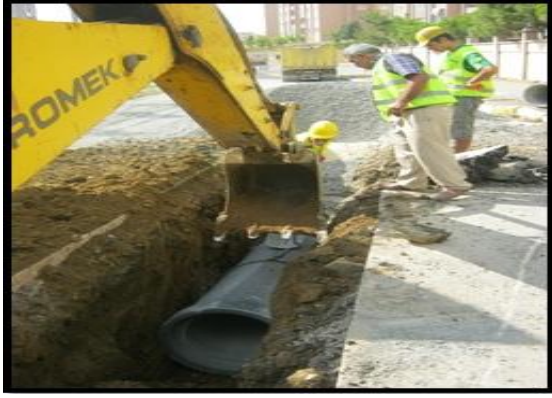
Atık Su Kanalı
