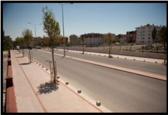
Bordür Tretuvar Çalışmaları
