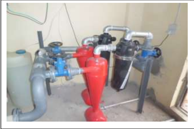
Yk.Alican ve Bekirhanlı Kum Filtre Cihazı takılması
