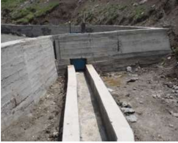
Su Alma Yapısı ve Sulama Kanalı
