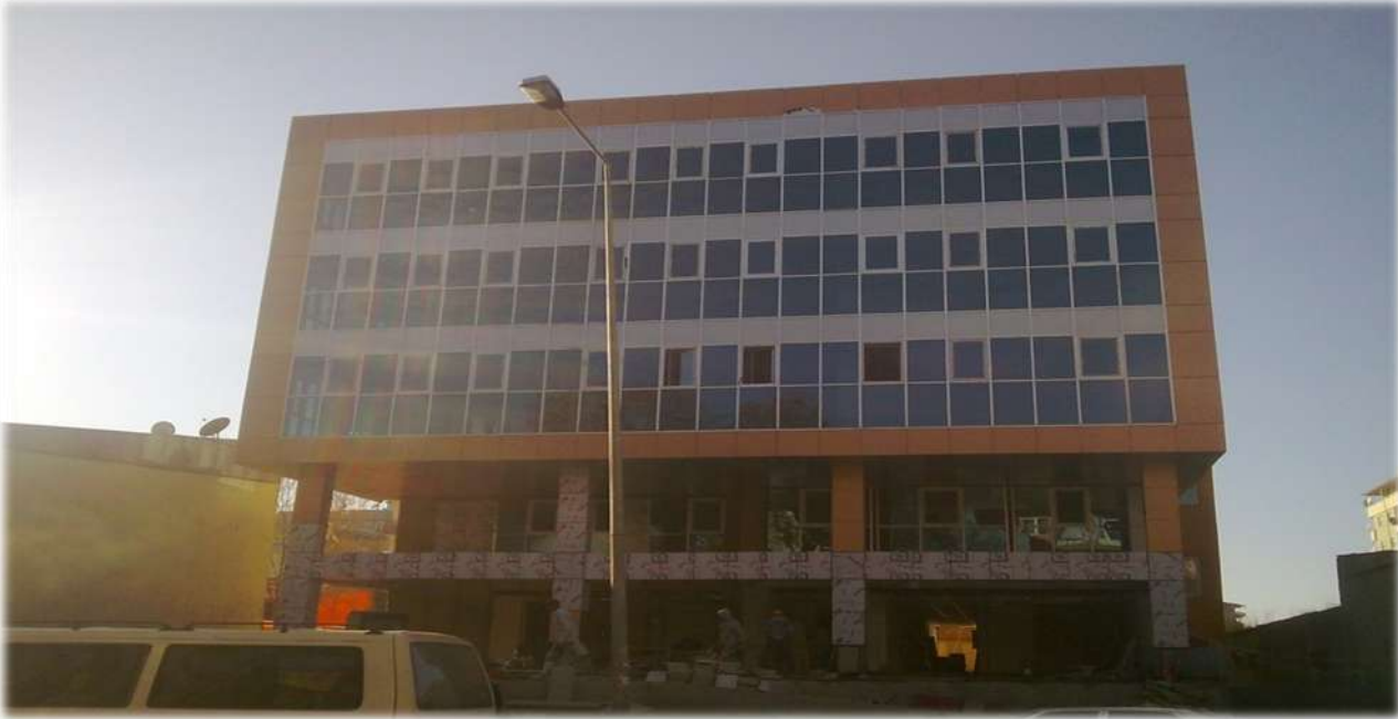
1 Nolu Sağlık Ocağı ve İl Sağlık Müdürlüğü Hizmet Binası
