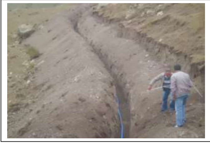
Yk.Aktaş Köyü ek içme suyu inşaatı
