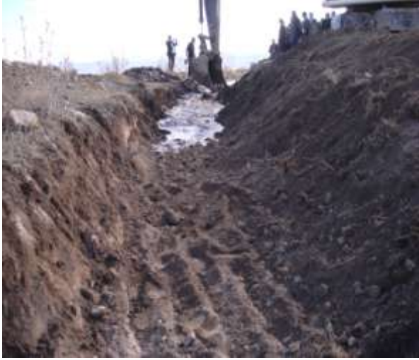
Sulama Kanalı Temizliđi
