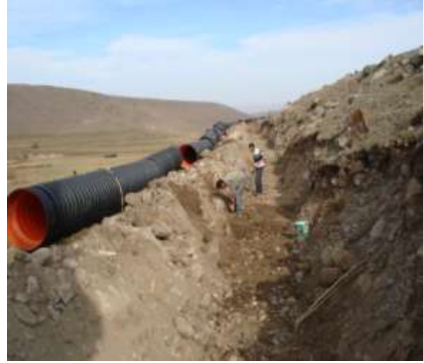
Kapalı Sistem Sulama Tesisi İnřaatı
