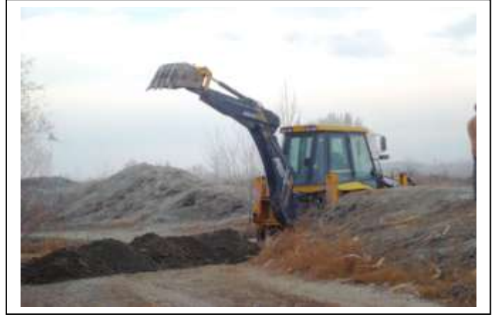
Kerimbeyli Ek Hat Döşenmesi
