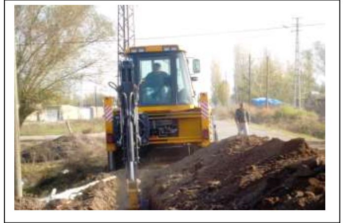
Yk.Alican ek hat döşenmesi
