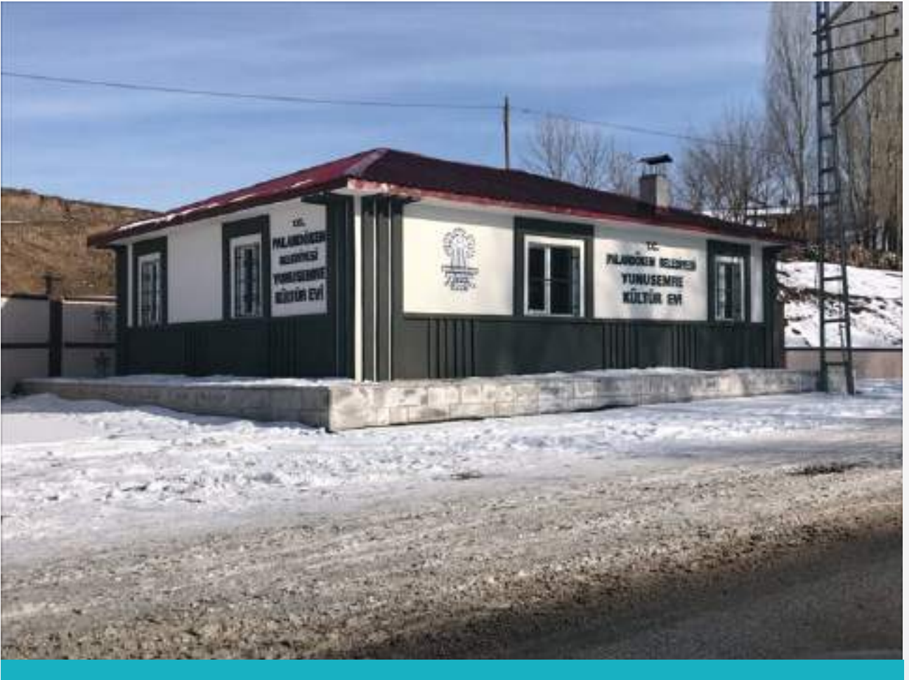
Tuzcu Mahallesi Taziye Evi Restorasyonu
